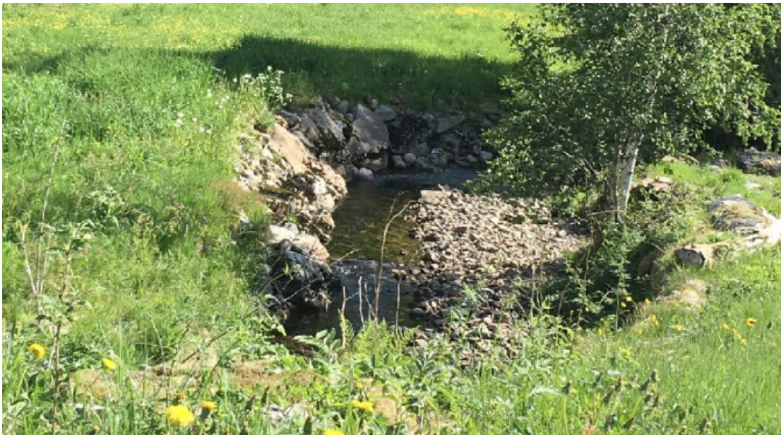
Figur 64. Fotografi fra befarings i området ved Erdalen Sør: Lite erosjon og liten vannføring i steinsatt bekk (nord).
