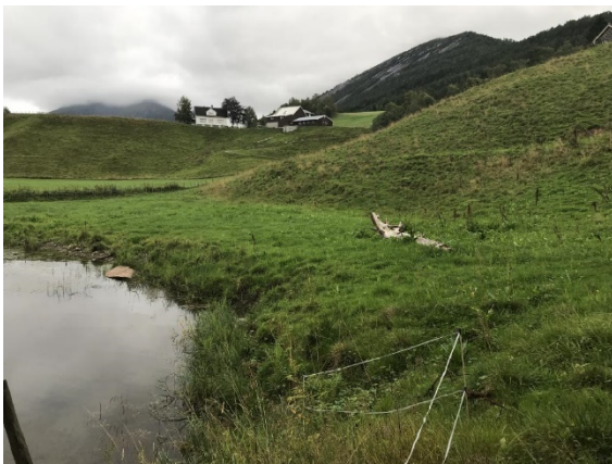
Figur 10 Ingen erosjon i elvebredd.
