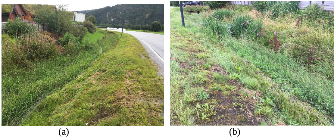
Figur 7 Fotografi fra befaring i området ved Vievegen: (a) og (b): Ingen erosjon i bekken.
