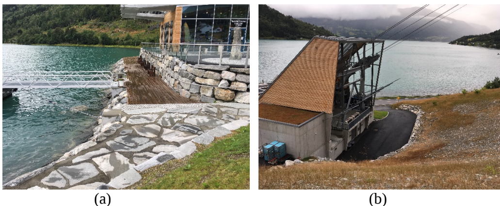
Figur 9 Fotografier fra befaringsområdet ved Gjølmunna: (a) steinplastring/forbygging ved butikken ved gondolbanen, (b) utsikt fra ledevoll ned til sjøen.
