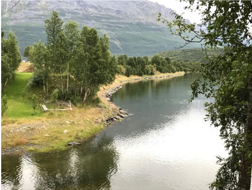
Figur 58 Signal dalselva er plastret langs sandbanken
