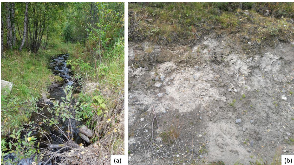
Figur 68 (a) Lite erosjon i elva. (b) Løsmasser blottet i skråning langs Fv. 868 viser finsand og grus.
