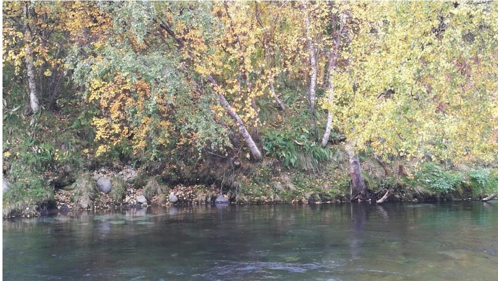
Figur 98 Erosjon langs elva.
