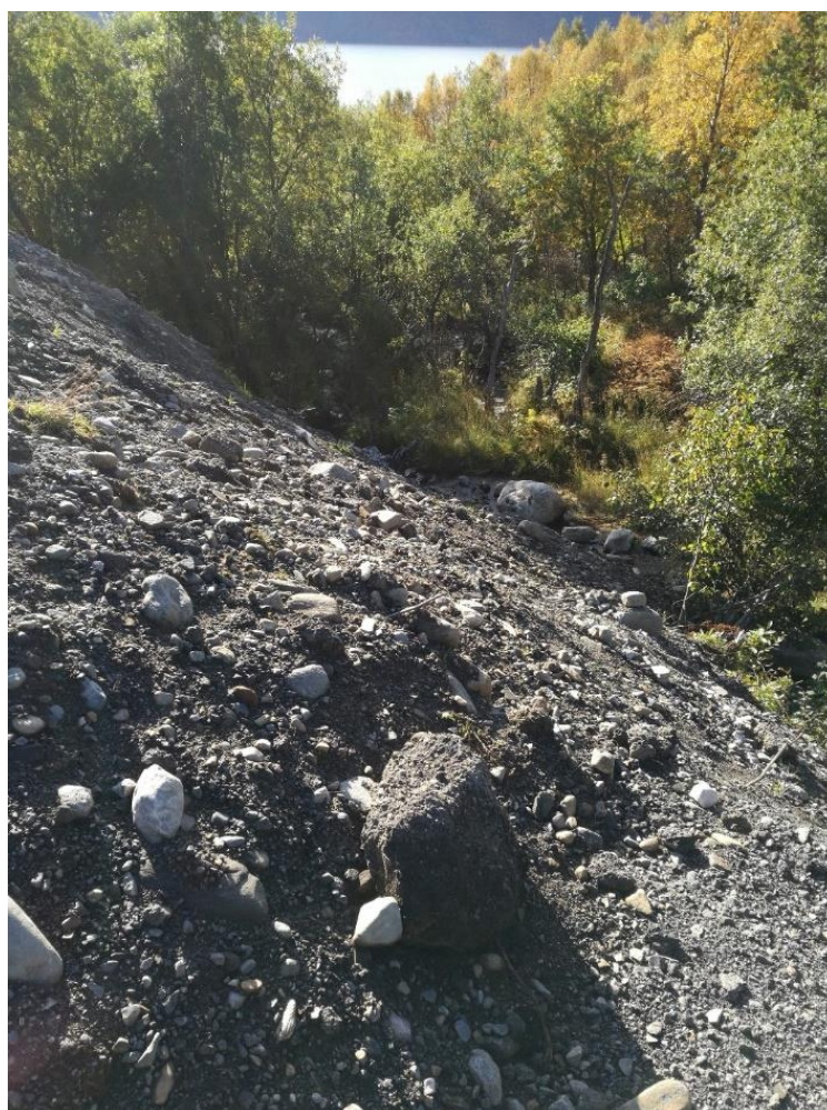
Figur 118 Terrenginngrep ved Doronelva.
