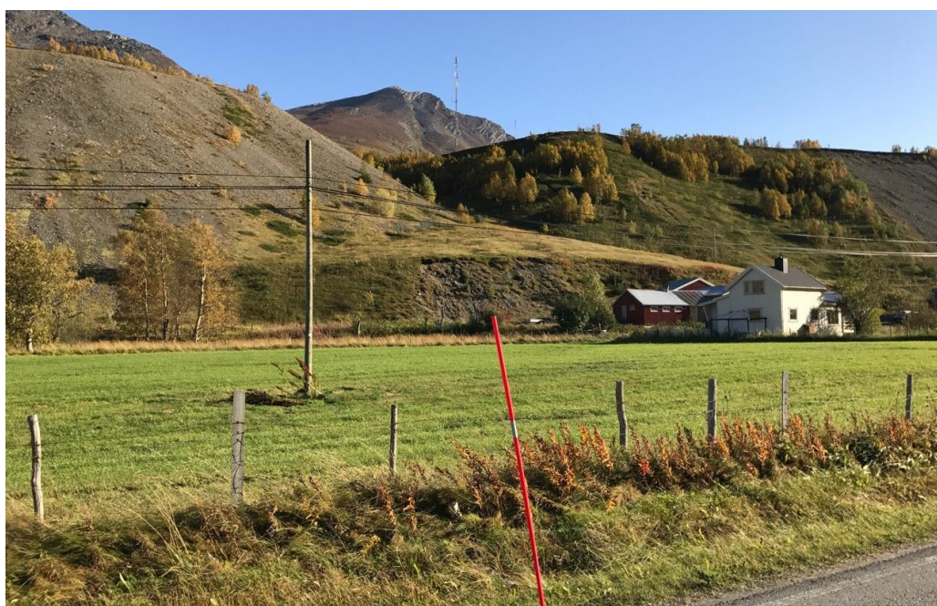
Figur 52 Erosjon i skråningen bak det hvite huset.
