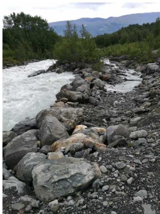
Figur 104 Oppdemning av elva ved foten av terrasseskråningen.
