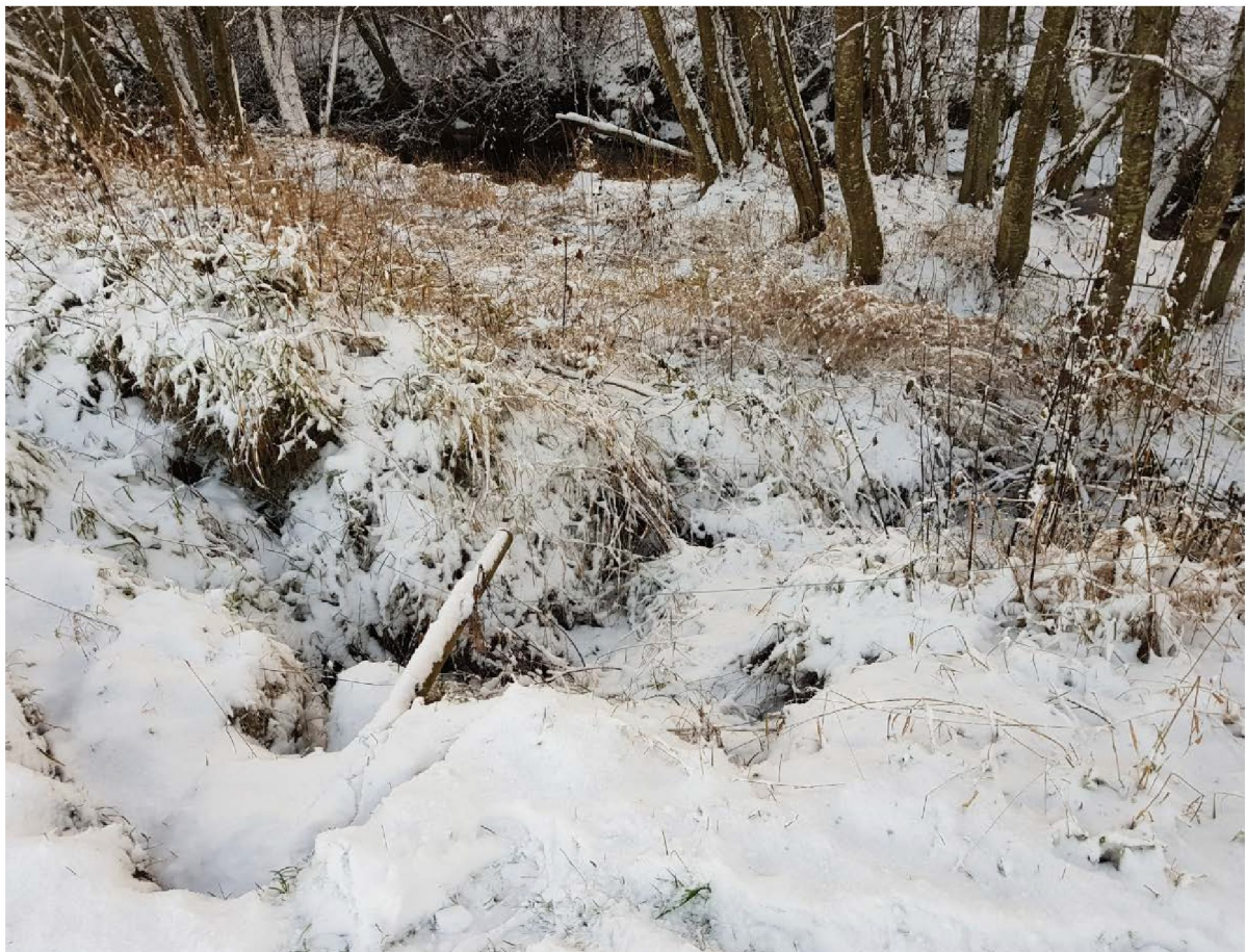
Figur 5-1 bilde nummer 55, sprekker i toppen av skråning mot elven.
