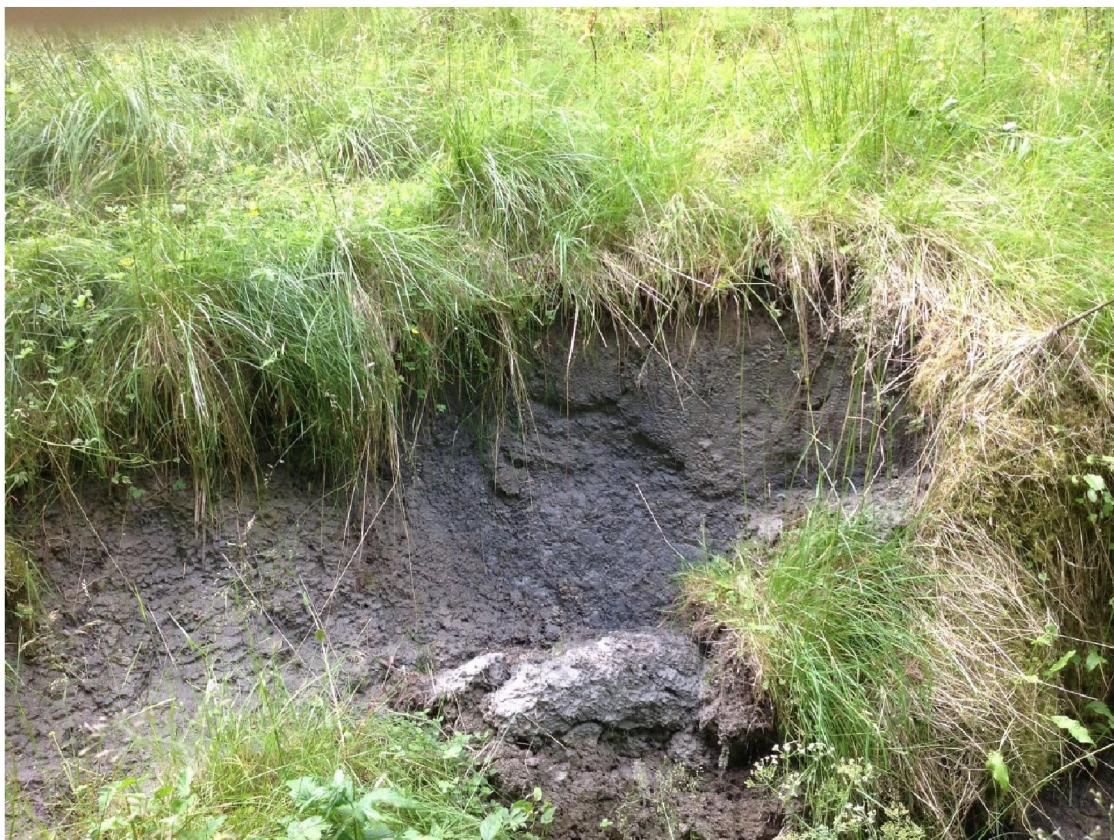
B 1- 66: Bunnsenkning (ca 1-1,5 m). Liten utglidning av kant (Placemark 25 RMo)
