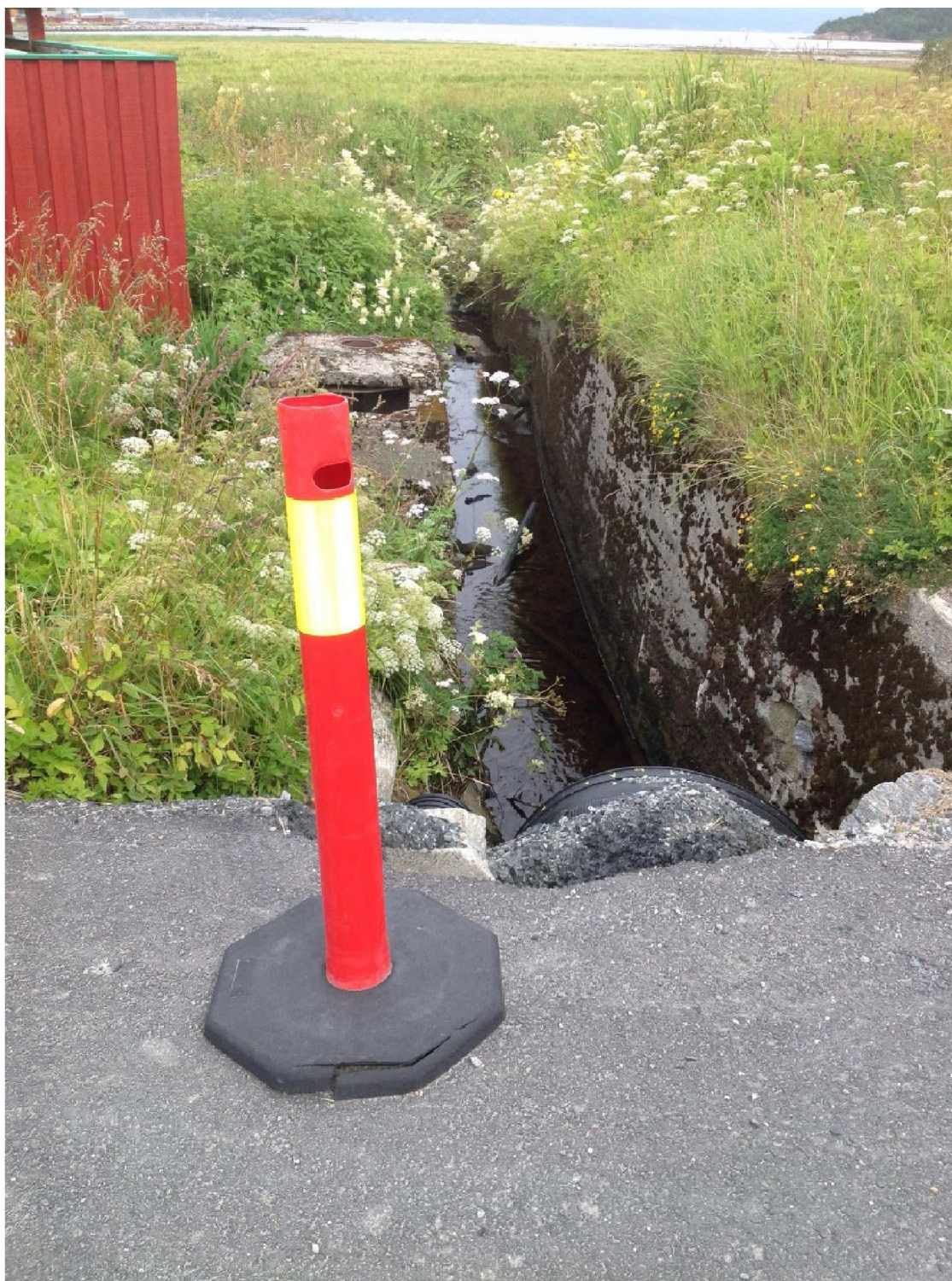
B 1- 101: Forbygning mur som ser stabilt ut (Placemark 18 RMo)
