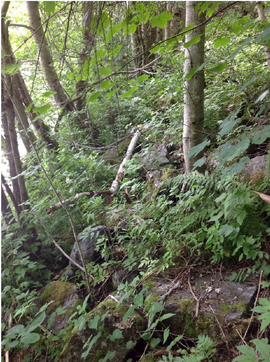
B 1- 42: Erosjonssikring i yttersvingen av elva. Mye småtrær som hindret observasjon. Ingen erosjon synlig (Placemark 2 RMo)
