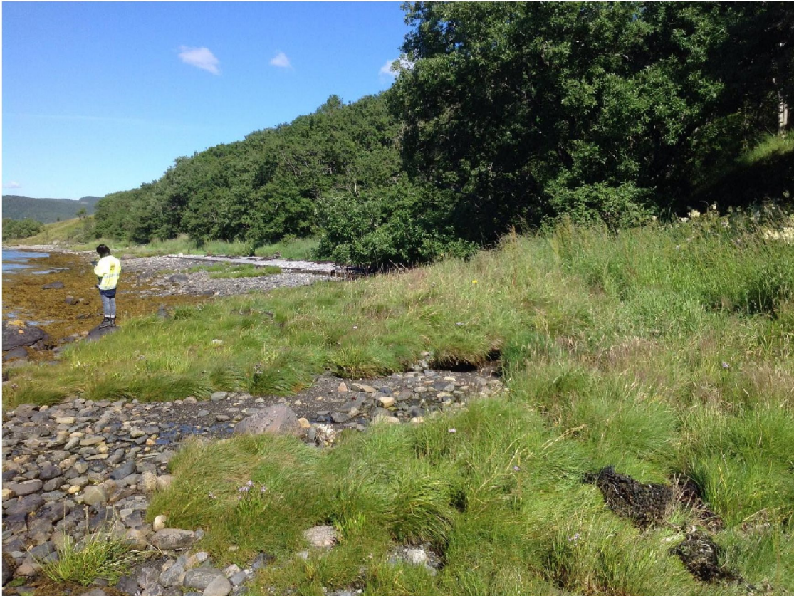
B 1- 31: Utløp dal med litt erosjon (Placemark 5 RMo)
