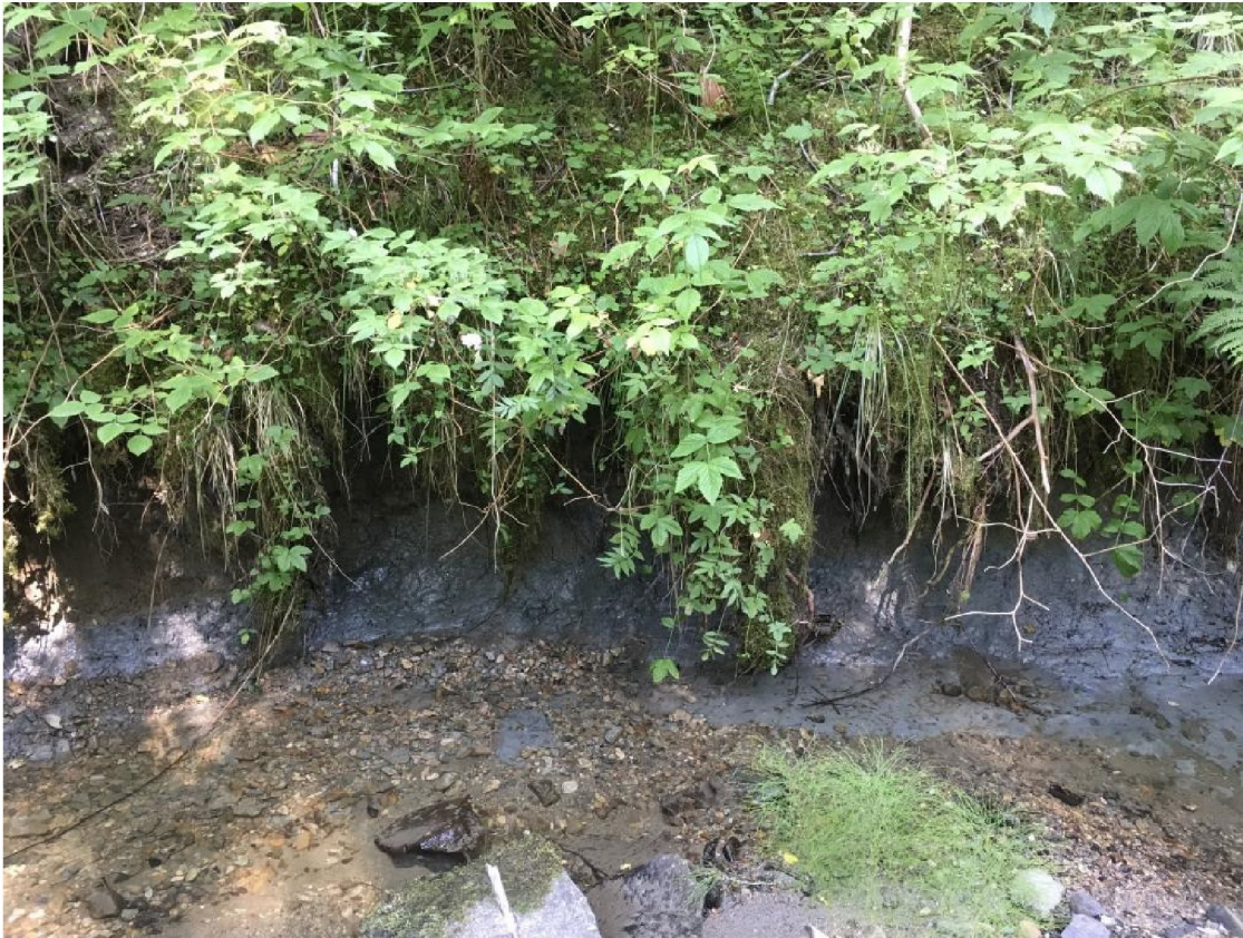
B 1- 64: Erosjon i yttersving av bekken. Synlig leire (Placemark 10 RMo)
