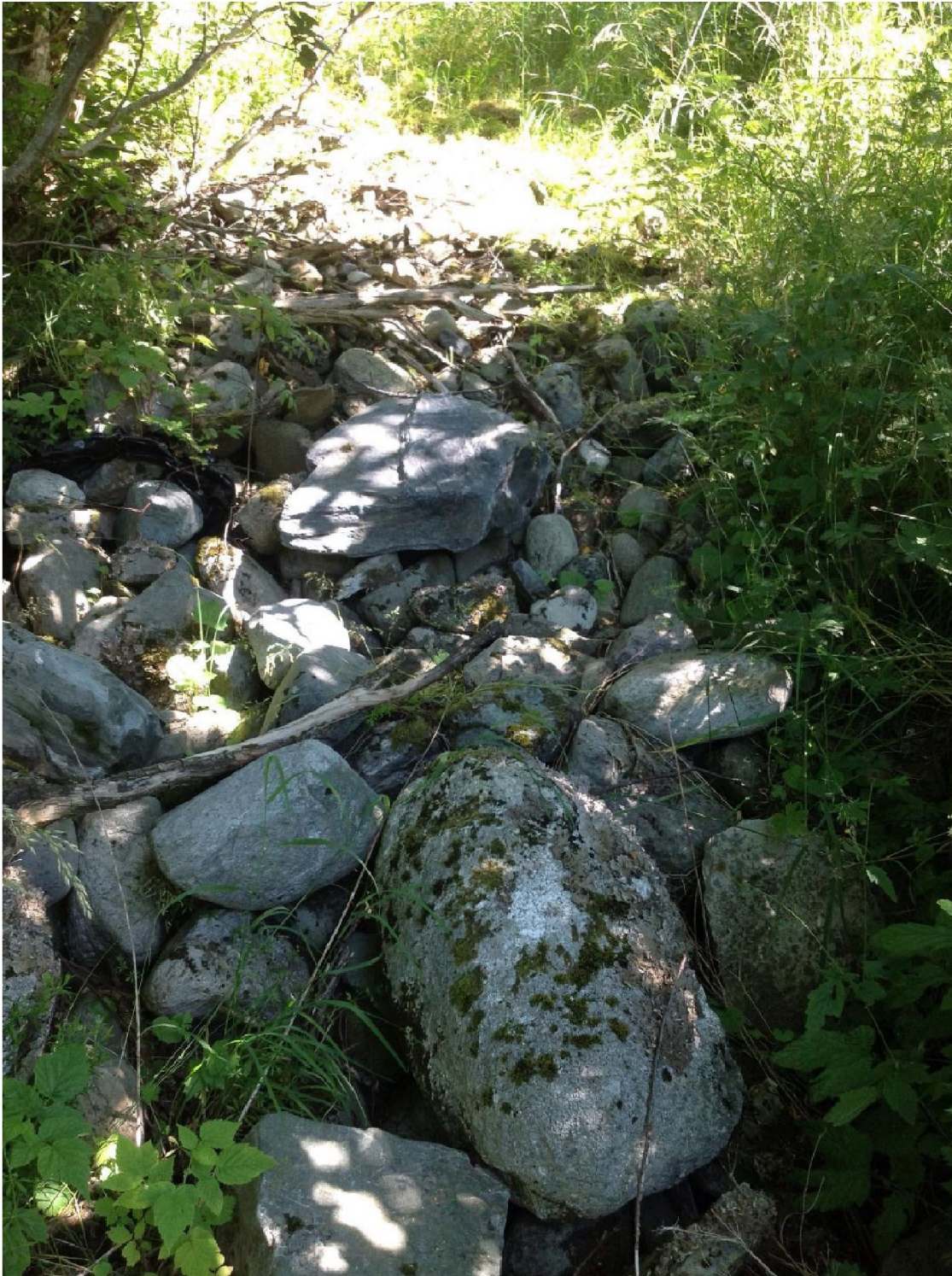
B 1- 28: Fylling. Skråningsdren i bratt skråning (Placemark 2 RMo).
