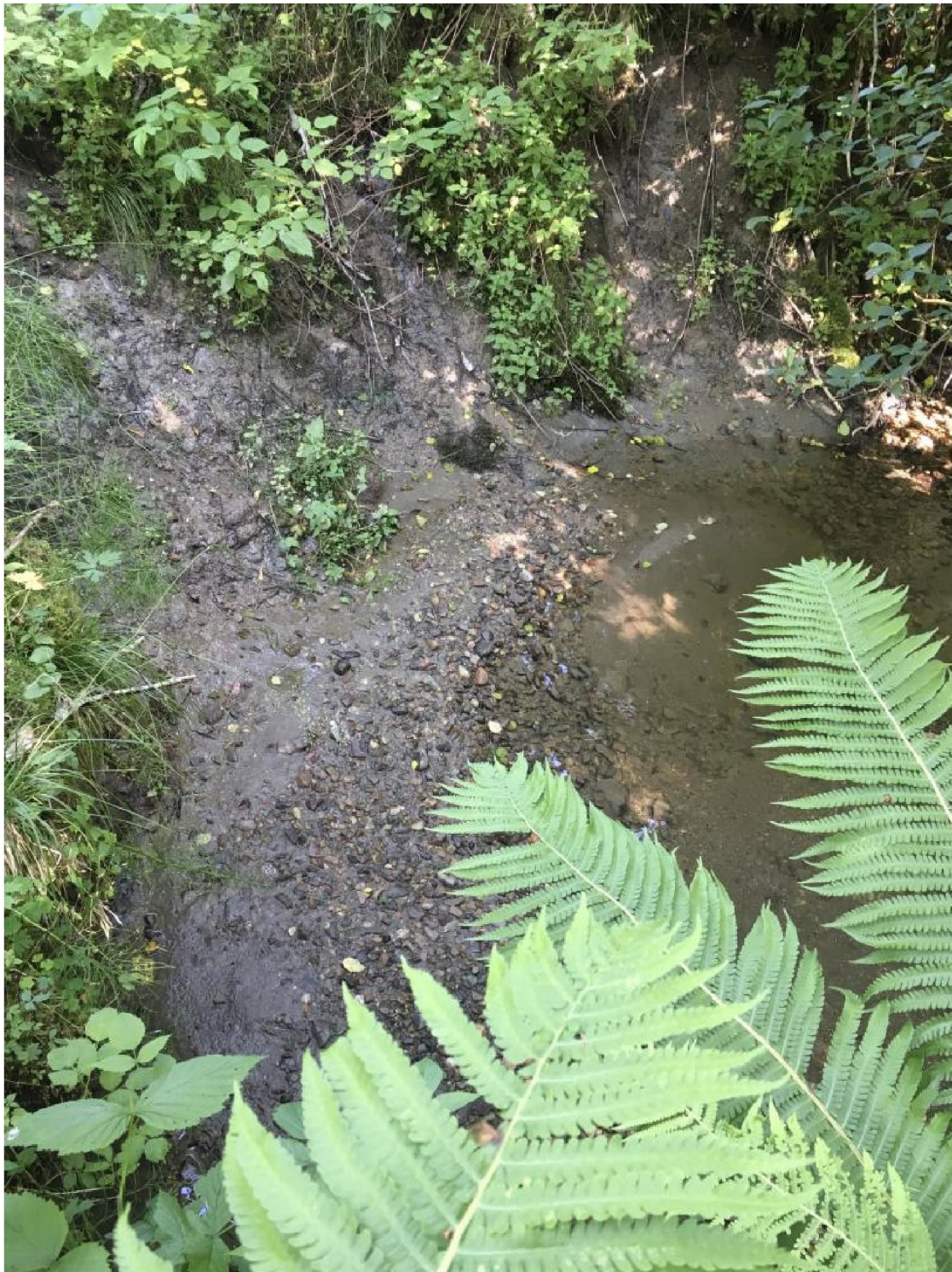
B 1- 62: Synlig bløtt leire. Litt erosjon i yttersving (Placemark 8 RMo)
