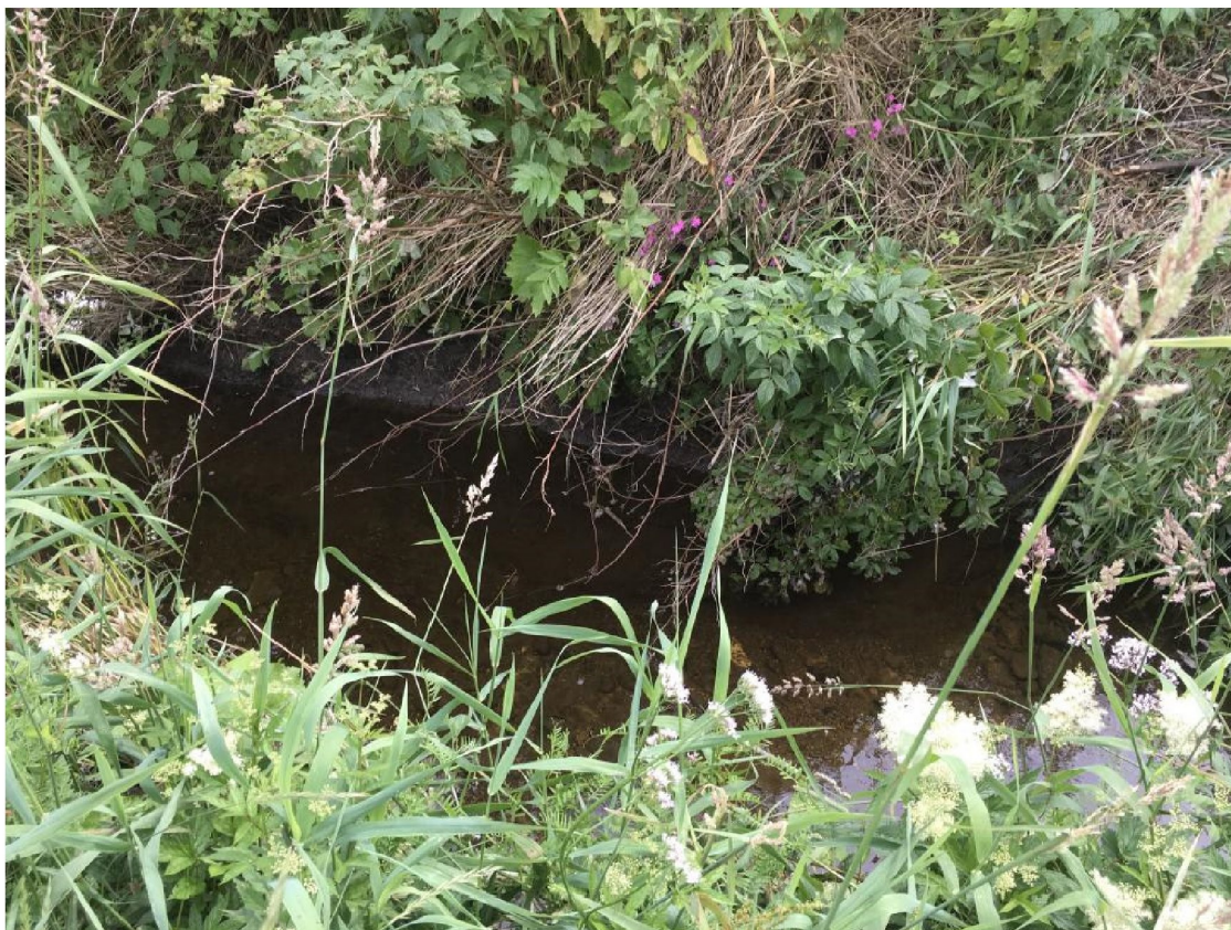
B 1- 97: Lite erosjon. Naturlig erosjon beskyttelse i bekkebunnen (Placemark 12 RMo)
