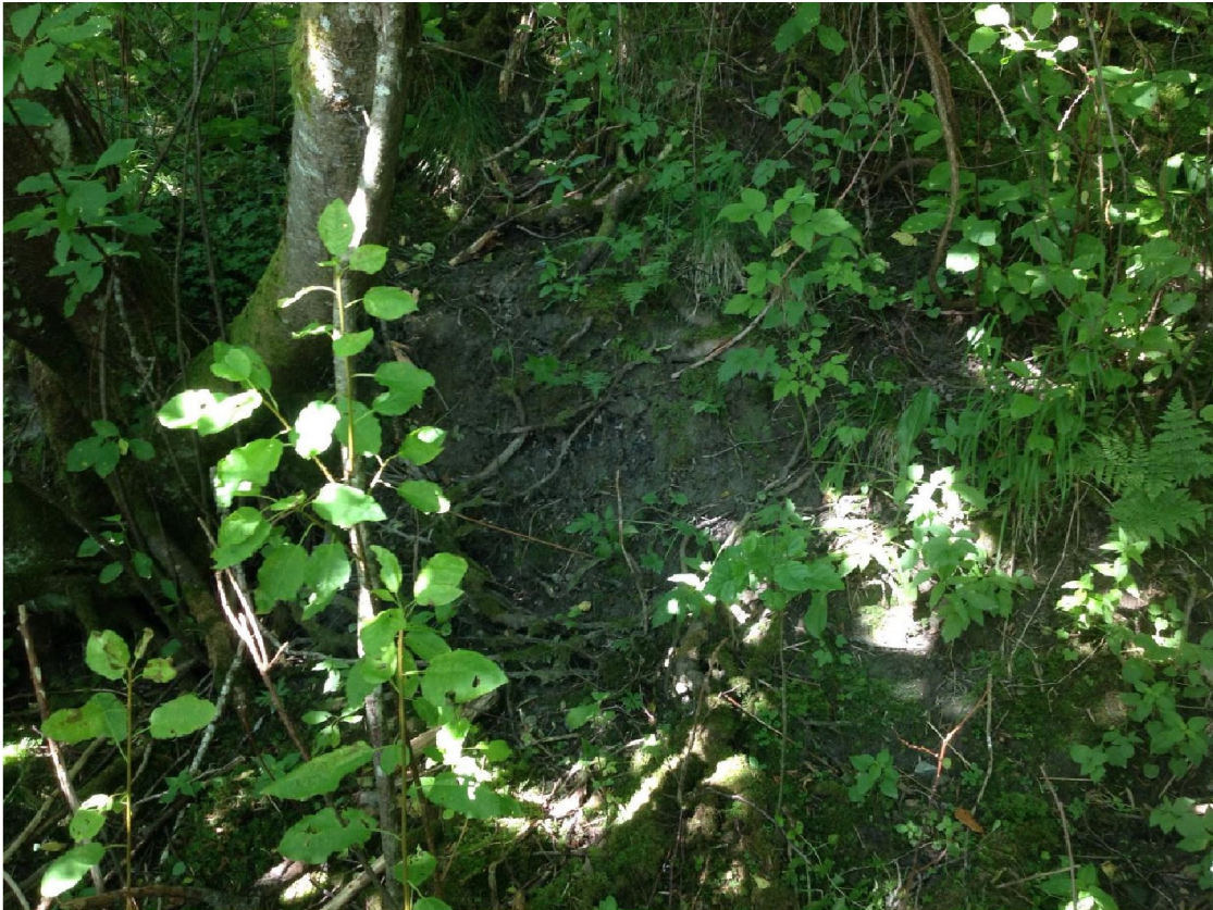
B 1- 44: Spor etter litt erosjon 1,5 meter opp fra elvenivå. Lite vannutslag har laget en ca. 1m dyp grøft (Placemark 8 RMo)
