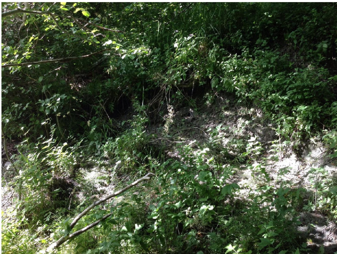
B 1- 48: Liten overflateutglidning. Ingen sikring i området (Placemark 10 RMo)
