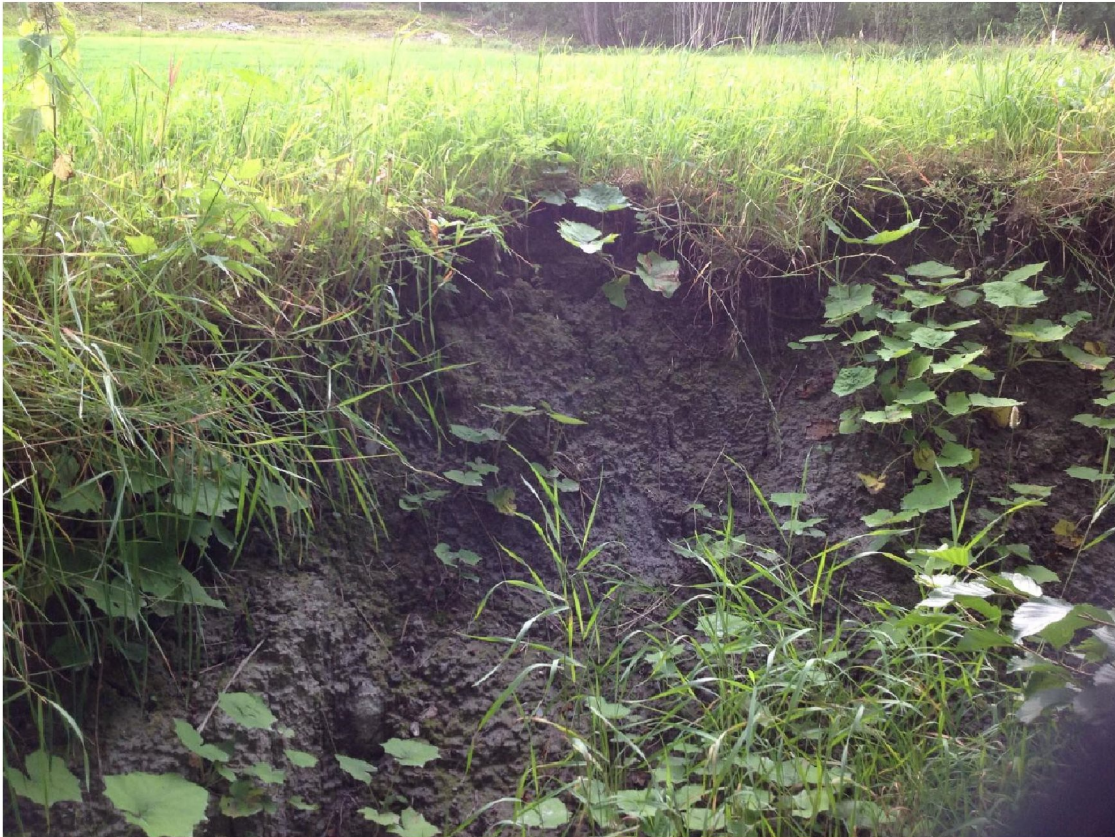
B 1- 92: Litt erosjon i yttersving (Placemark 2 RMo)
