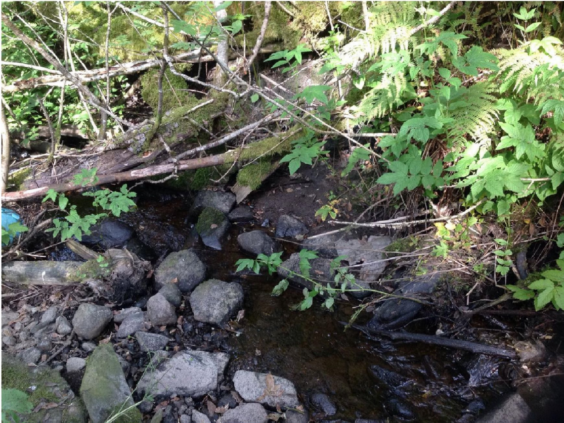
B 1- 76: Litt erosjon i siden. Synlig leire (Placemark 8 RMo)
