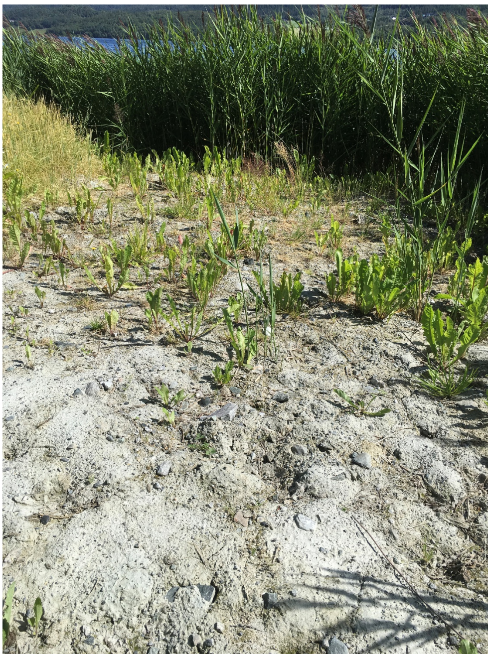
B 1- 27: Fylt med overskuddsmasse 10 x 8 m og ca. 0.5 m tykt (B 13:53 TLe)
