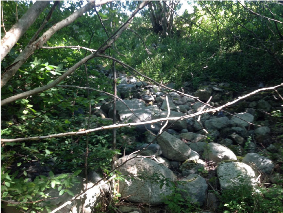
B 1- 29: Fylling. Skråningsdren i bratt skråning (Placemark 3 RMo)
