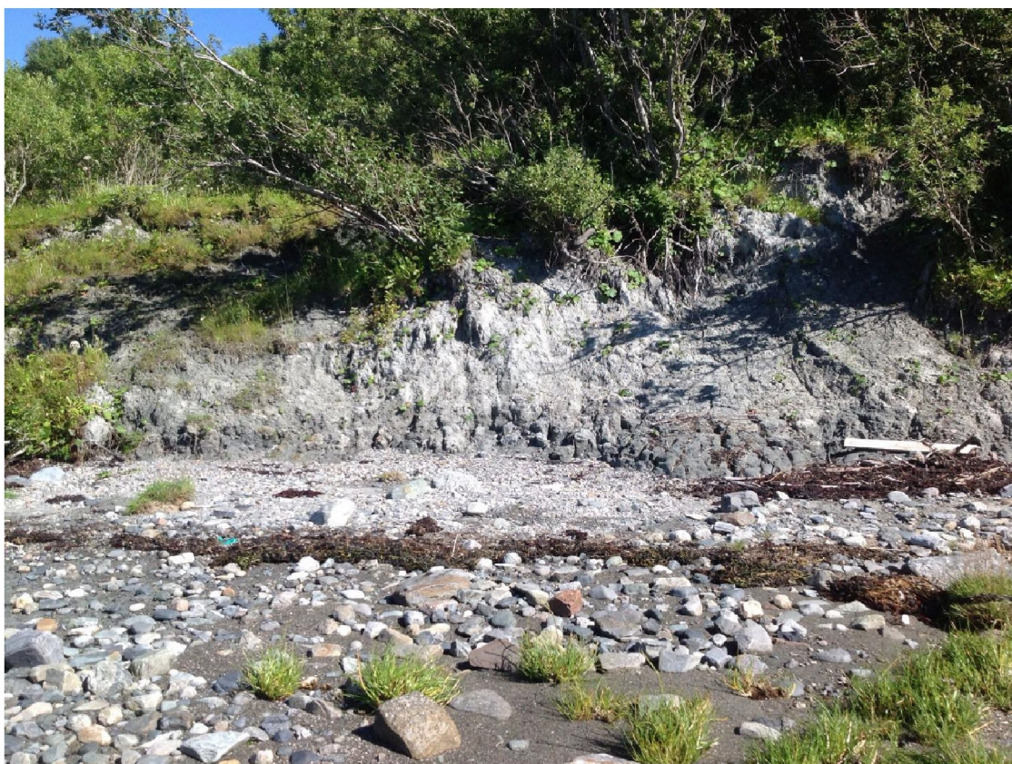
B 1- 36: Erosjon i foten av skråninger der sjøen står på (Placemark 9 RMo)
