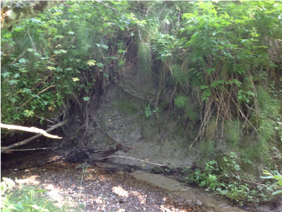
B 1- 61: Litt erosjon i yttersving. Synlig leire. Klart vann (Placemark 6 RMo)
