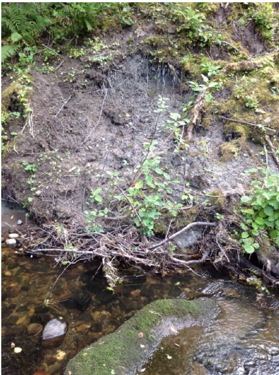
B 1- 9: Erosjon i bekken som førte til en liten glidning (Erosjon RMo)
