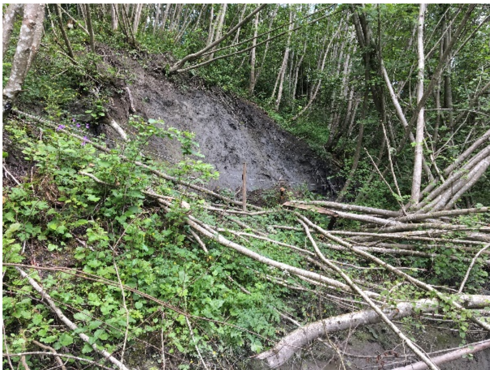
B 15 Utglidning (noe erosjon).
