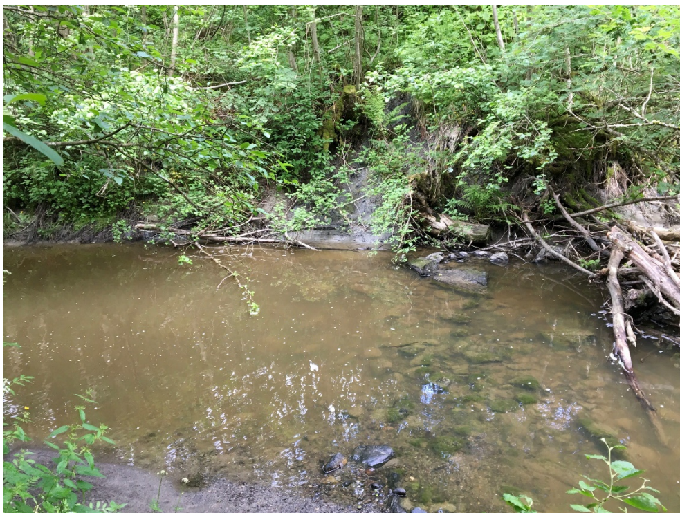
B 28 Overflateglidning (noe erosjon).
