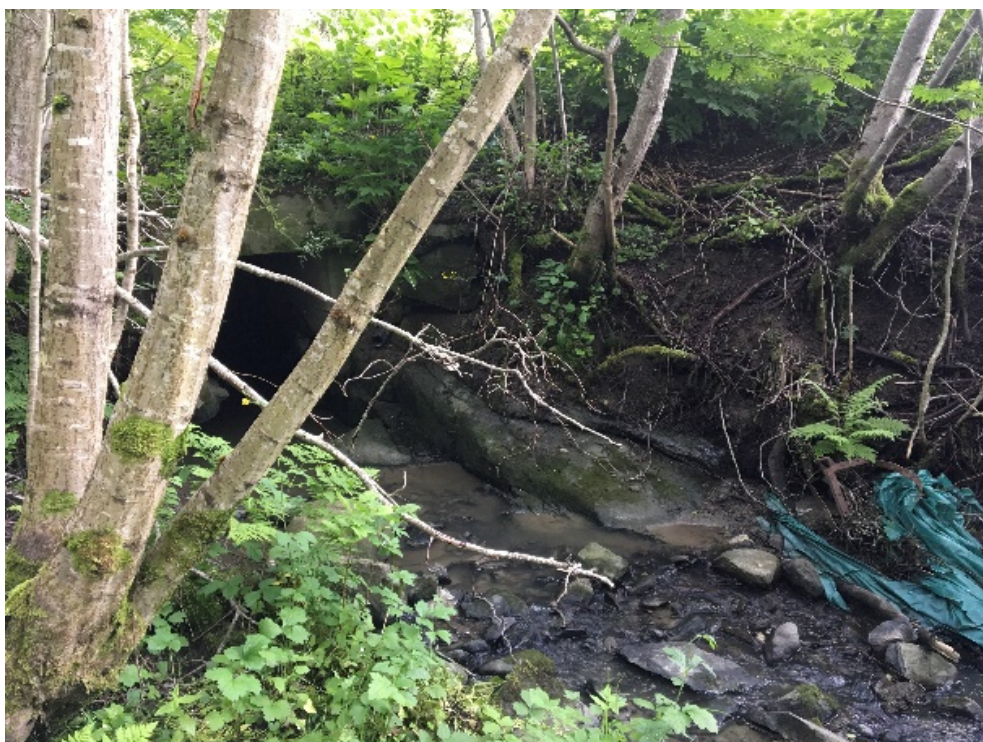
B 13 Overflateglidninger (noe erosjon). Kulvert på berg.
