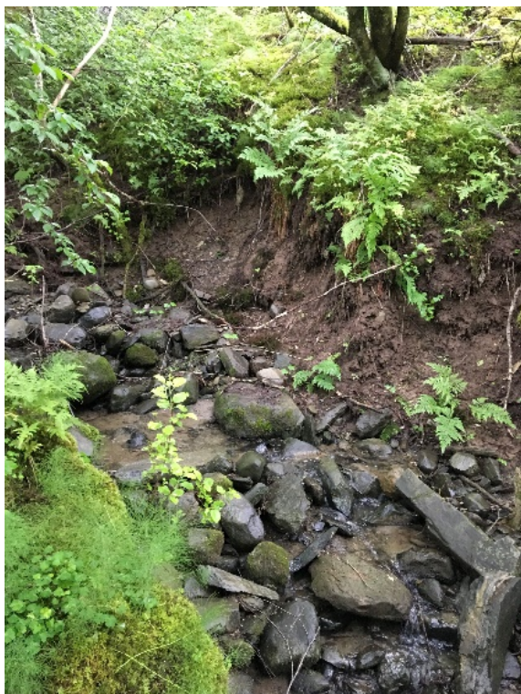
B 4 Erosjon i sideterreng. Stein i bekkebunn (litt erosjon).
