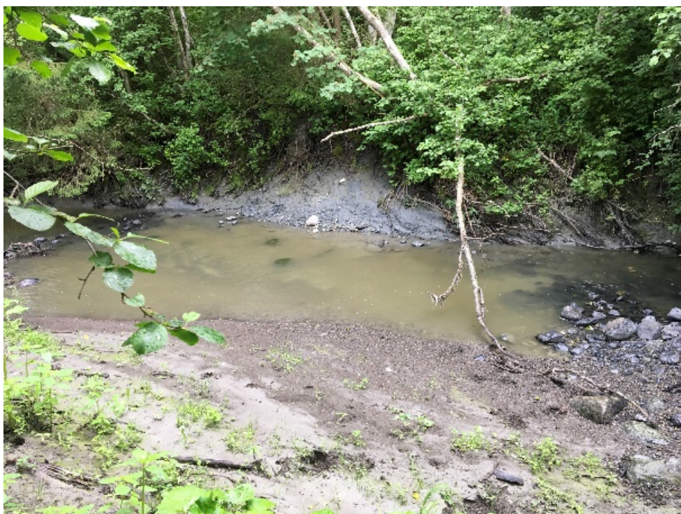
B 21 Utglidning (noe erosjon).
