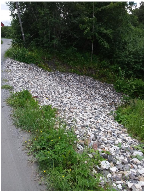
B 10 Erosjonssikring av bekken sør for Bergshaugen (nabosone 1509 Vaksdal).
