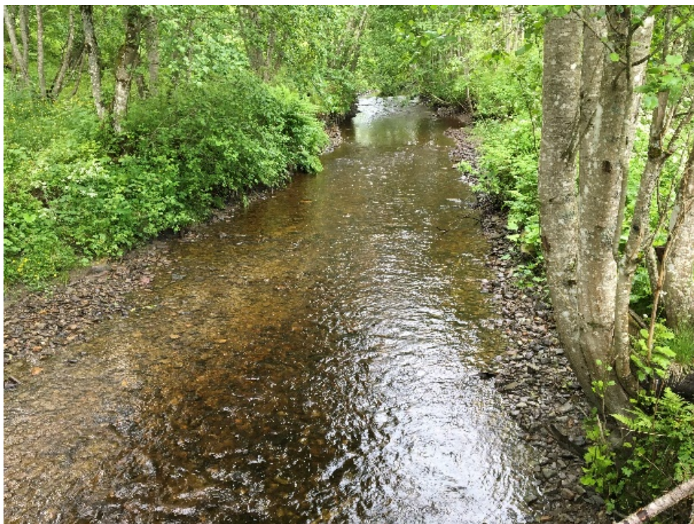
B 12 Mye stein i elveløp (ingen erosjon).
