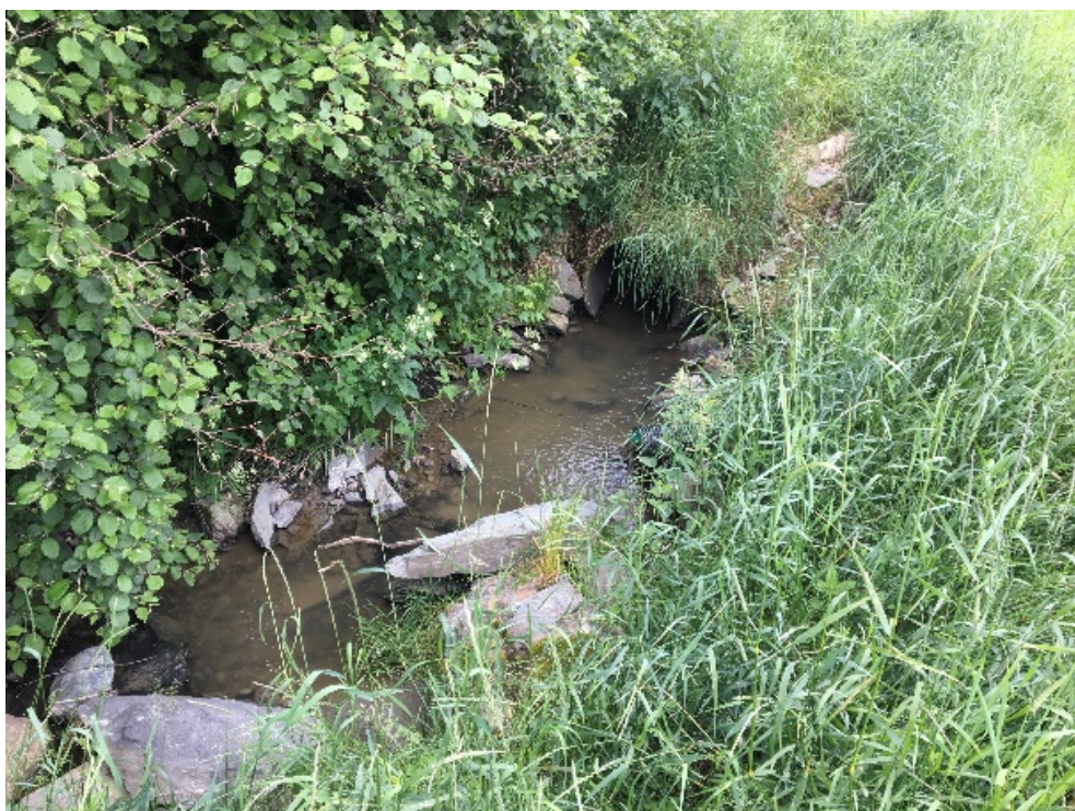
B 3 Bekken lagt i rør ca. 15 m. Erosjonssikring langs åkeren (ingen erosjon).
