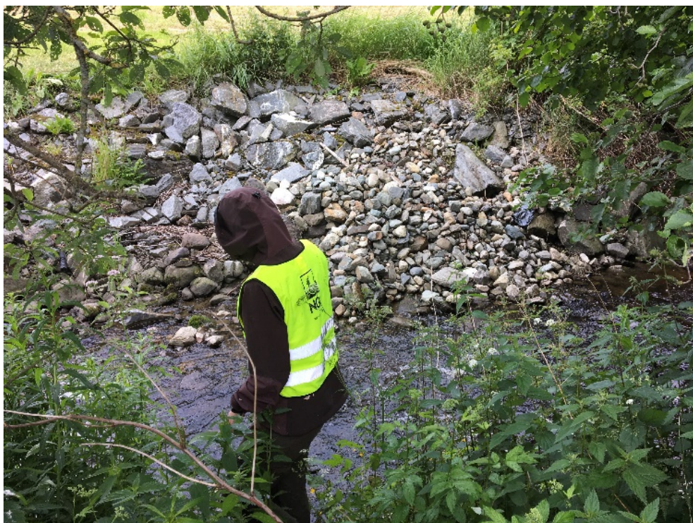
B 16 Elva er plastret i ytterkant (ingen erosjon).
