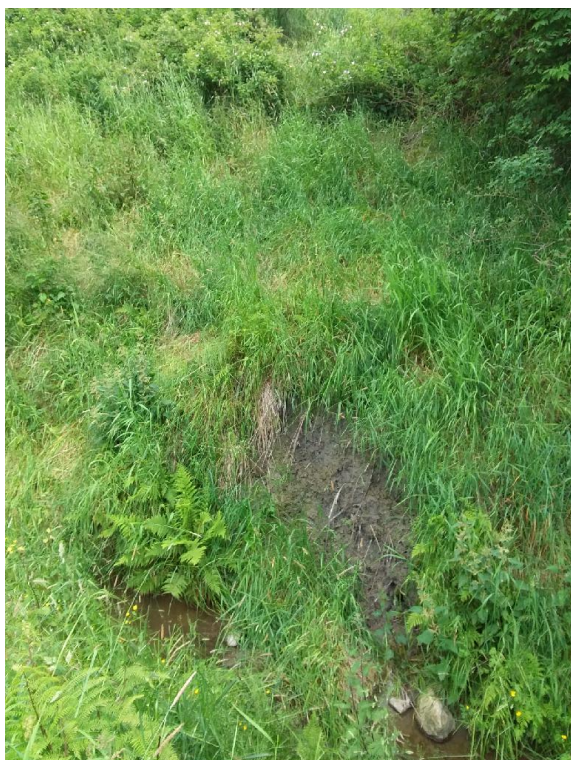
B 3 Overflateglidning (noe erosjon).
