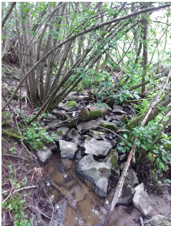
B 8 Mye stein i bekkeløp (ingen erosjon).
