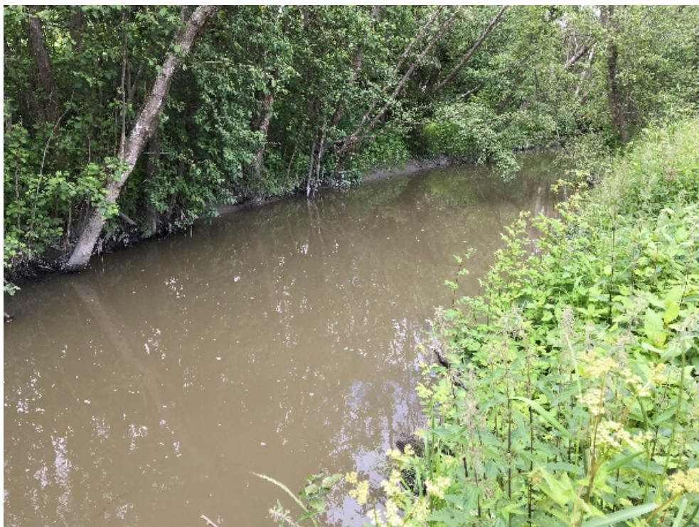
B 18 Litt erosjon.
