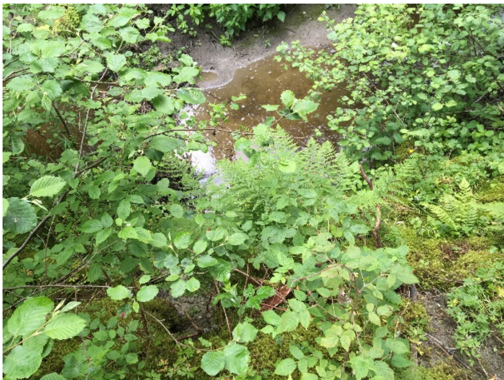
B 4 Noe graving i yttersving (litt erosjon).
