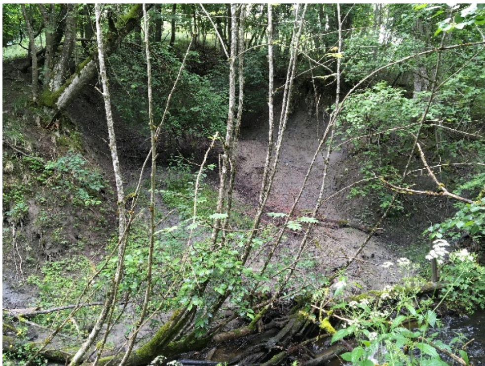
B 10 Aktiv erosjon i yttersving. Større utglidninger.
