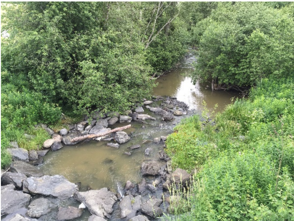
B 2 Veifylling med erosjonssikring (ingen erosjon).
