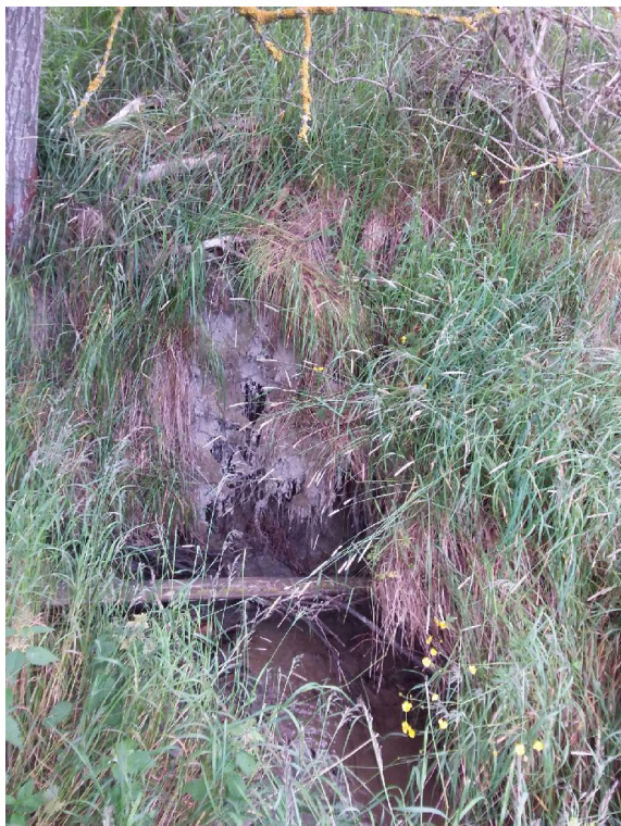
B 4 Erosjonsgrop (noe erosjon).
