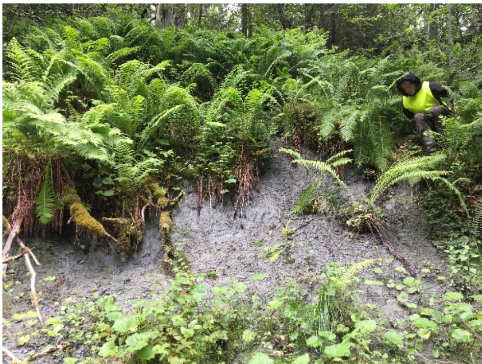
B 2 Liten utglidning (noe erosjon).
