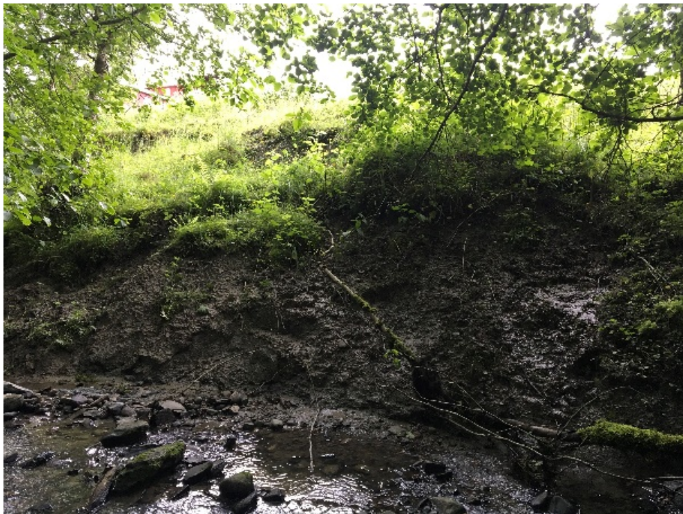
B 6 Utglidninger langs bekken. Utglidninger/skredkanter i skråningen opp mot gården. Sandig materiale (noe erosjon).
