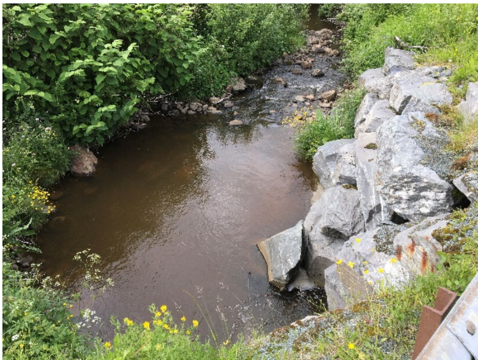
B 2 Kulvert ved Fv 118. Utløpet er erosjonssikret (ingen erosjon).
