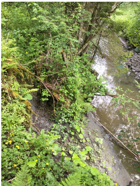
B 10 Overflateglidning (noe erosjon).
