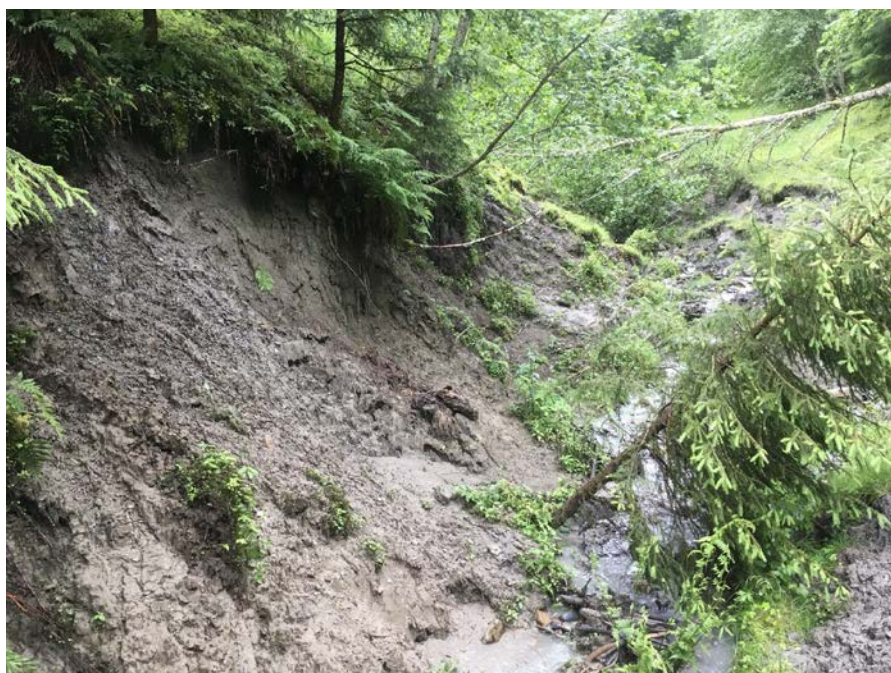
Bilde 3 Erosjon i ravine fra Saukinn til Innlegghaugen. Adkomst av borerigg er vanskelig. Bilde mot sørvest.
