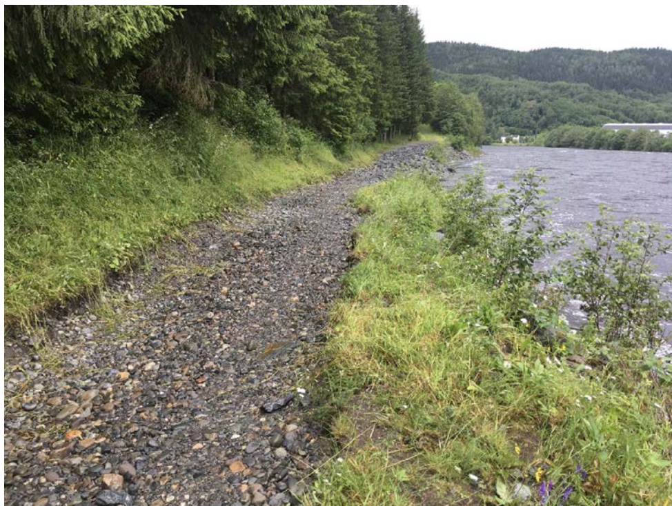
Bilde 6 Vei langs elvekant. Plastret. Bratt skråning i bakkant av veien. Kan elven gå over veien og grave i den bratte skråningen bak? Bilde mot nord.
