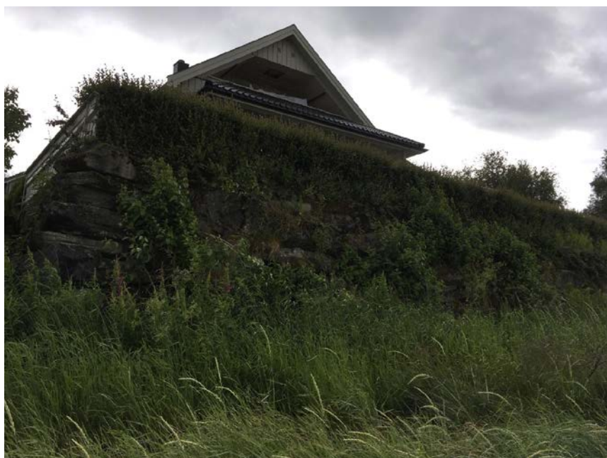
Bilde 4 Steinmur på flere meter som hus er bygget på ved strandsonen. Bilde mot sør.
