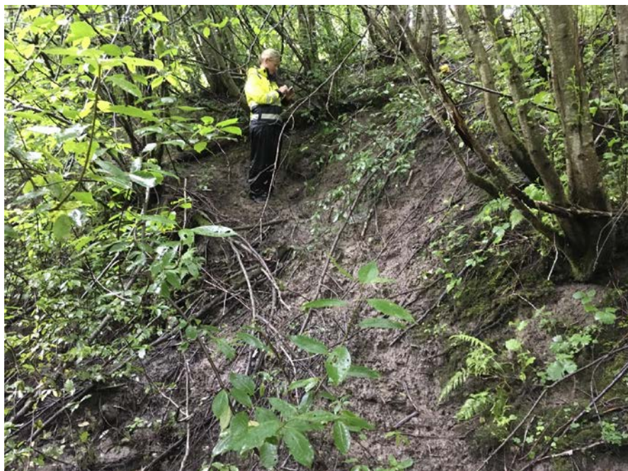
Bilde 5 Noe erosjon. Bilde mot øst.
