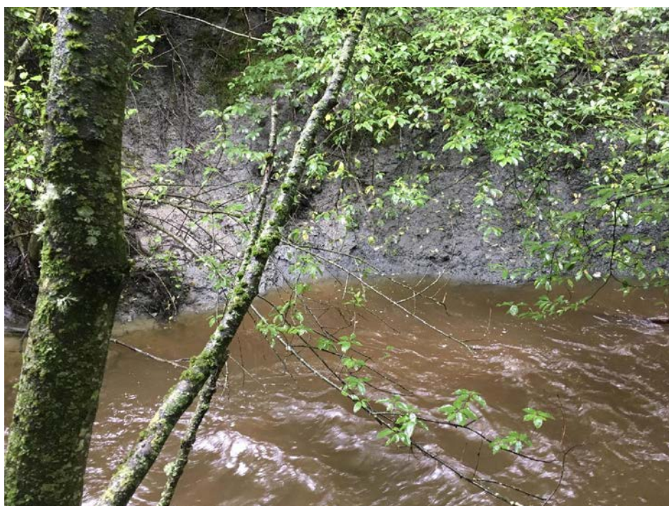
Bilde 2 Noe erosjon, bilde tatt mot øst og viser østsiden av elva.
