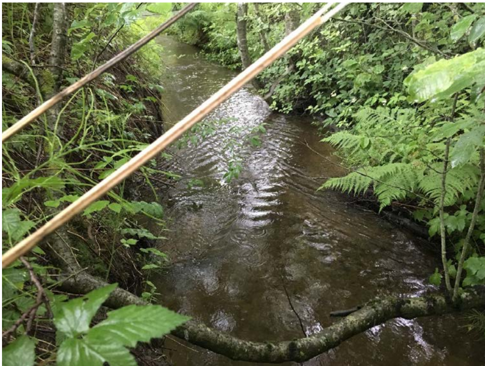
Bilde 1 Korsdalsbekken. Litt erosjon i yttersvinger. Bilde mot sørøst.
