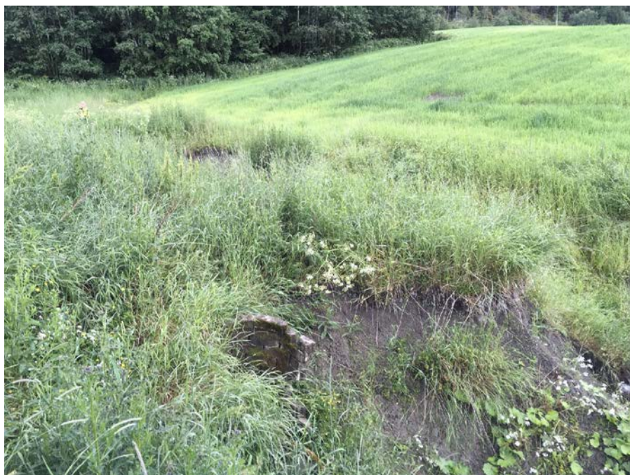
Bilde 8 Aktiv erosjon ved åker opp mot Rv. 72. Bekkelukking ødelagt. Bilde tatt mot sørvest.
