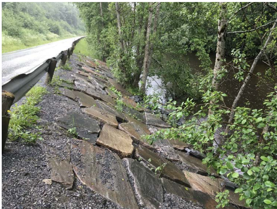
Bilde 1 Plastring ned mot Verdalselva ved Fv.757. Bilde mot nord.
