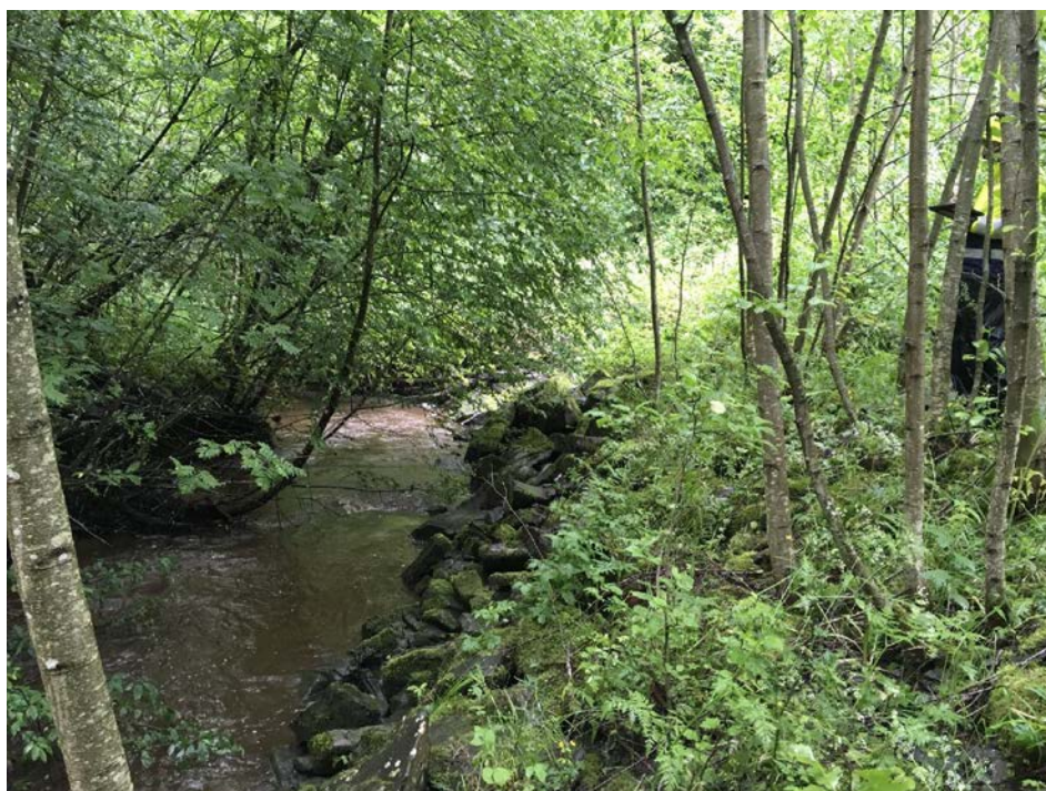
Bilde 1 Elven Leirå er plastret med stor stein helt sør i kvikkleirsonen. Bilde mot sør.
