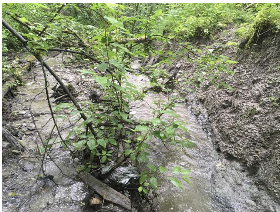
Bilde 6 Noe til aktiv erosjon ved snitt I-I i ravinen vest før Gudding gård. Bilde mot nord.
