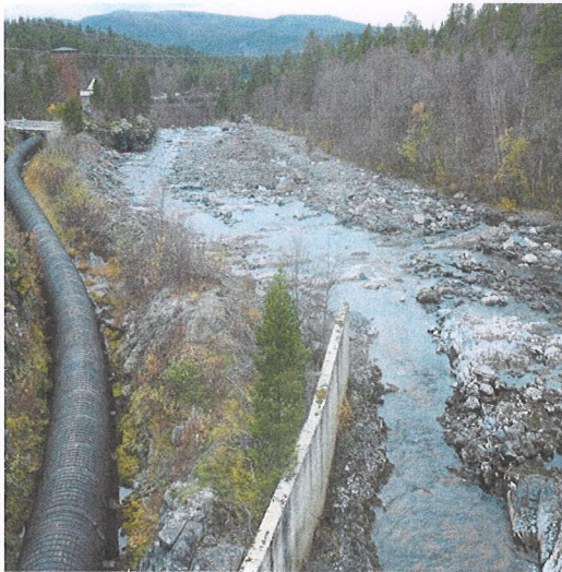
Bilde 3: Rør sett fra dam Svingetårn i bakgrunnen. Elvestrekning med noe overløp
