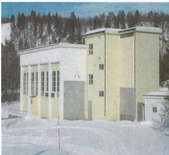
Bilde 5: Bygning fra adkomst
