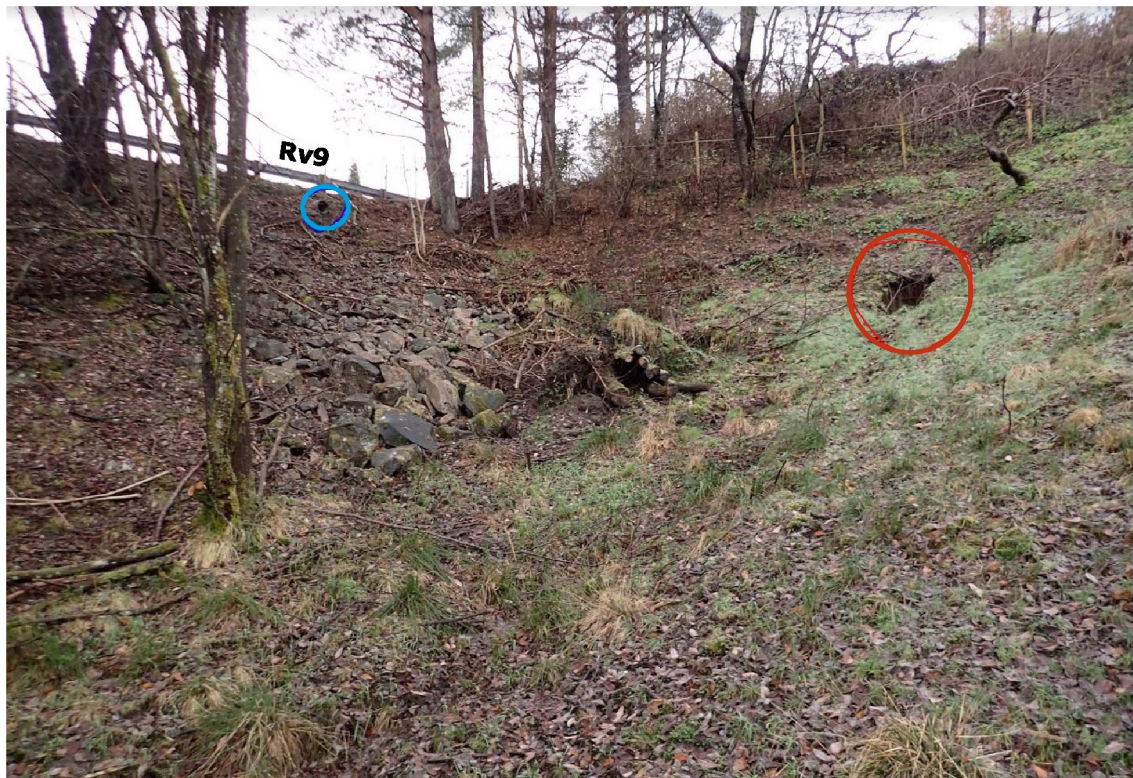
Figur 4 Stikkrenne er markert i blått. Begynnende skred er markert i rødt. Datert 17. november 2017
