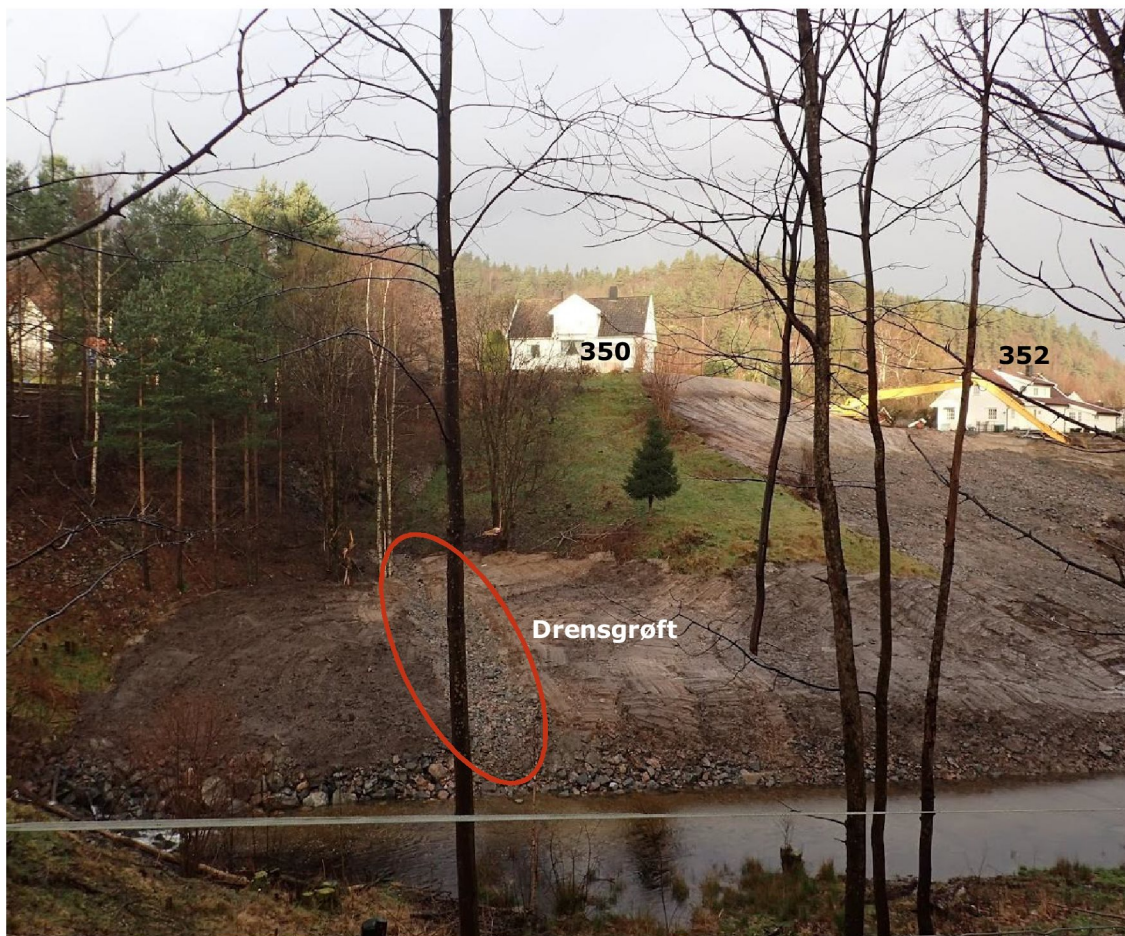
Figur 3 Sikringstiltak pr. 21. november 2017. Plastret bekkekant og drengrøft.
