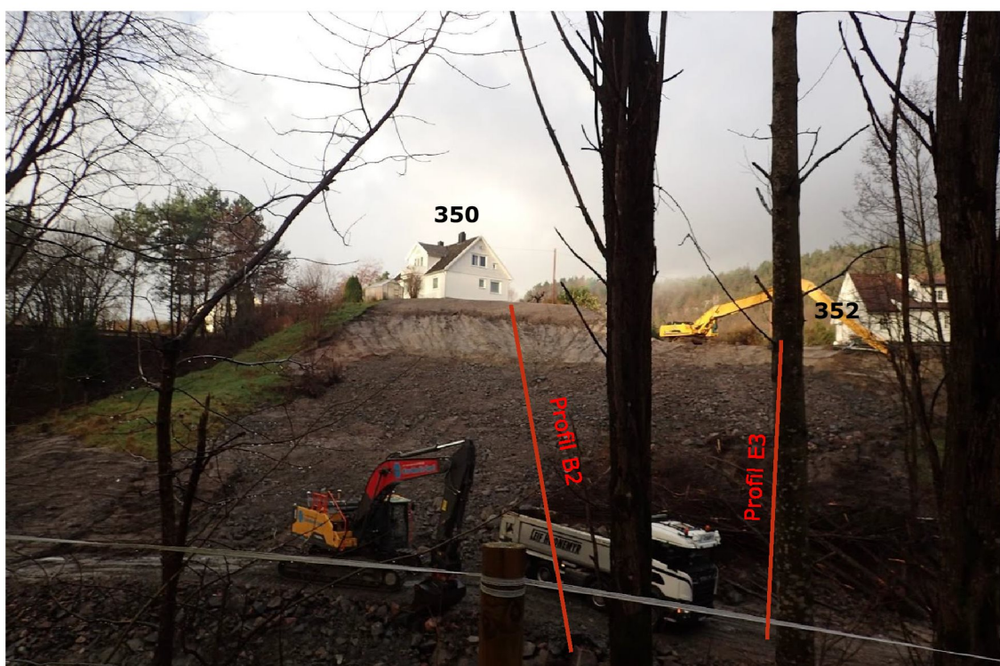
Figur 2 Sikringstiltak pr. 24. november 2017. Avlastning og motfylling
