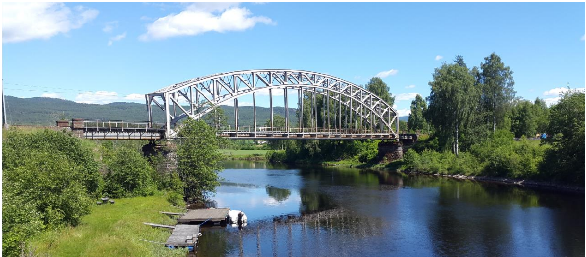
Figur 6.18: Bilde av jernbanebrua mottatt fra Sauherad kommune.
