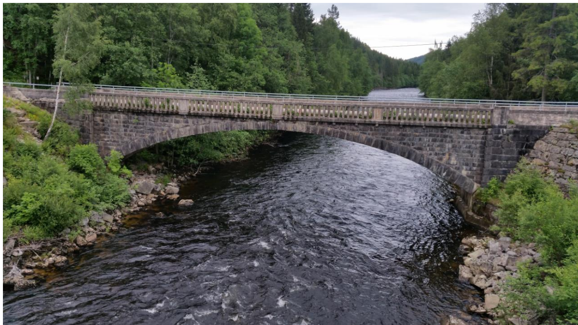
Figur 6.12: Bilde av gamle Folkestad bru mottatt fra Bø kommune.
