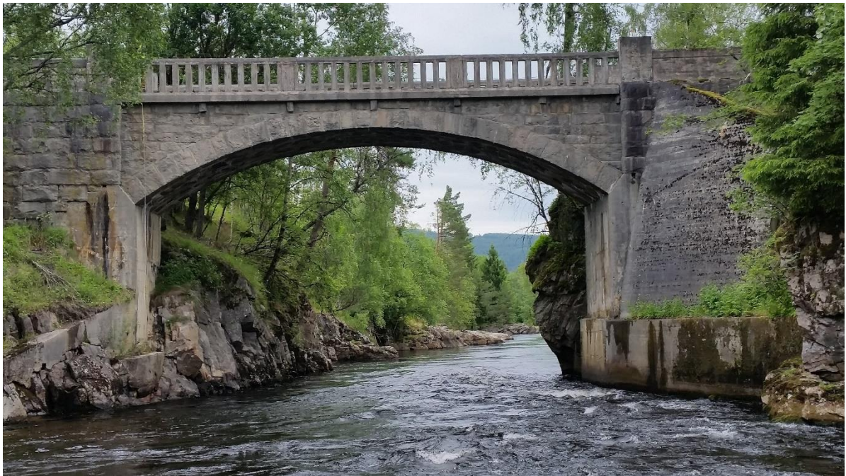
Figur 6.16: Bilde av Mannebru mottatt fra Bø kommune.
