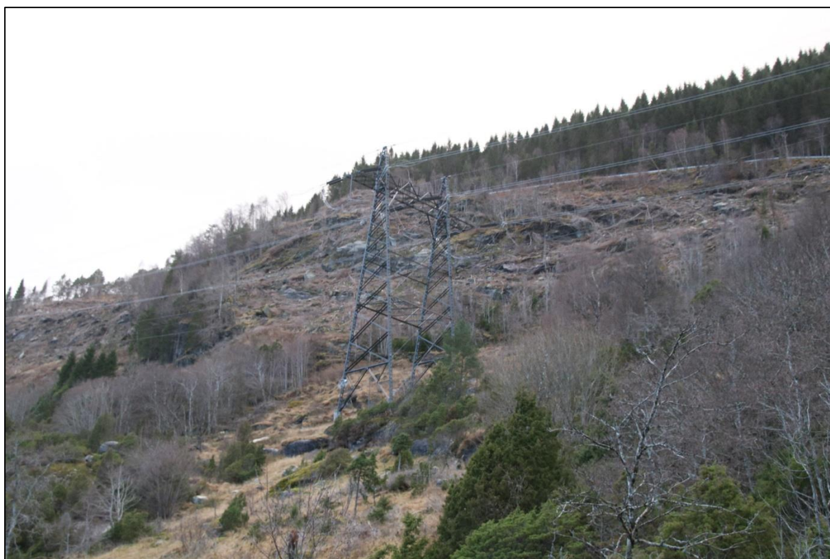
Figur 15: Oversikt øvre deler av potensielt løsneområde for steinsprang.
