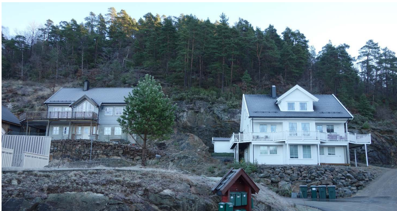
Foto 7: Hus lengst SV i feltet som kan være skredutsatt.
