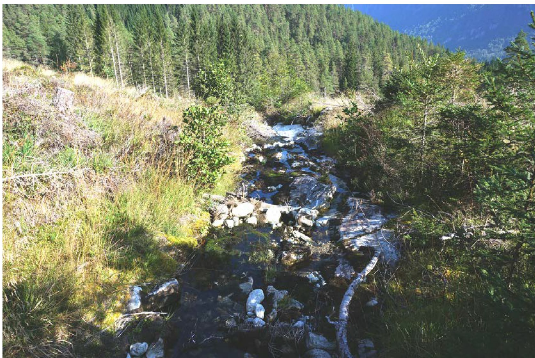
Figur 5. Samme bekk som på figur 4. Langs bekken er det lagt opp en enkel forbygning langs løpet ovenfor eksisterende byggefelt. Bilde fra punkt 679.
