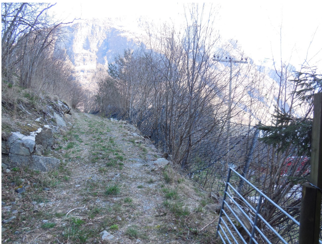
Figur 12 Wirenett satt opp ved Hjødna for å stanse eventuelle steinsprang
