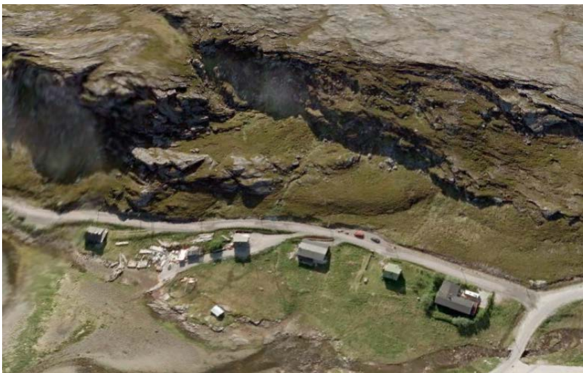
Figur 10 Langbuktvengen 3-7. Kilde: Norge i 3D
