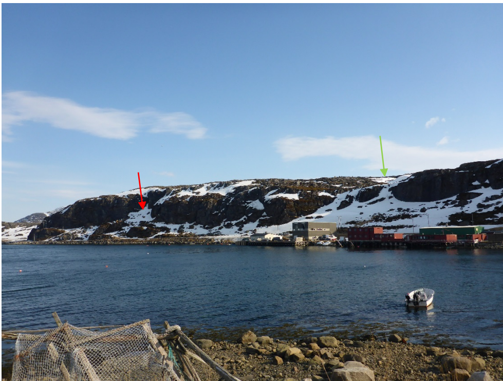
Figur 14. Østlig del av Havneområdet. Området der snøskred har krysset veggen antydnet med rød pil. Grønn pil: Mulig område for sørpeskred.
