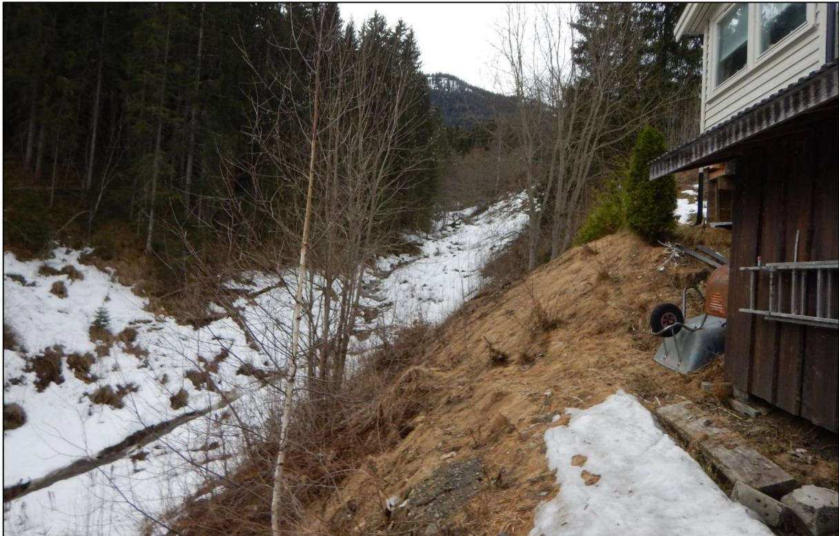
Figur 20: Ravinen ved Sørvollbakkin 45, der deformasjoner tilsier en ustabil ravinekant.
