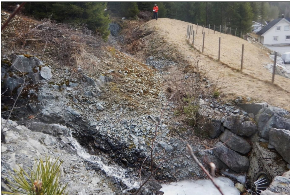
Figur 14: Den lille vollen bygd i overkant av Spangrud boligfelt, for å lede vann inn i kulverten med inntak i bildets nedre høyre hjørne.
