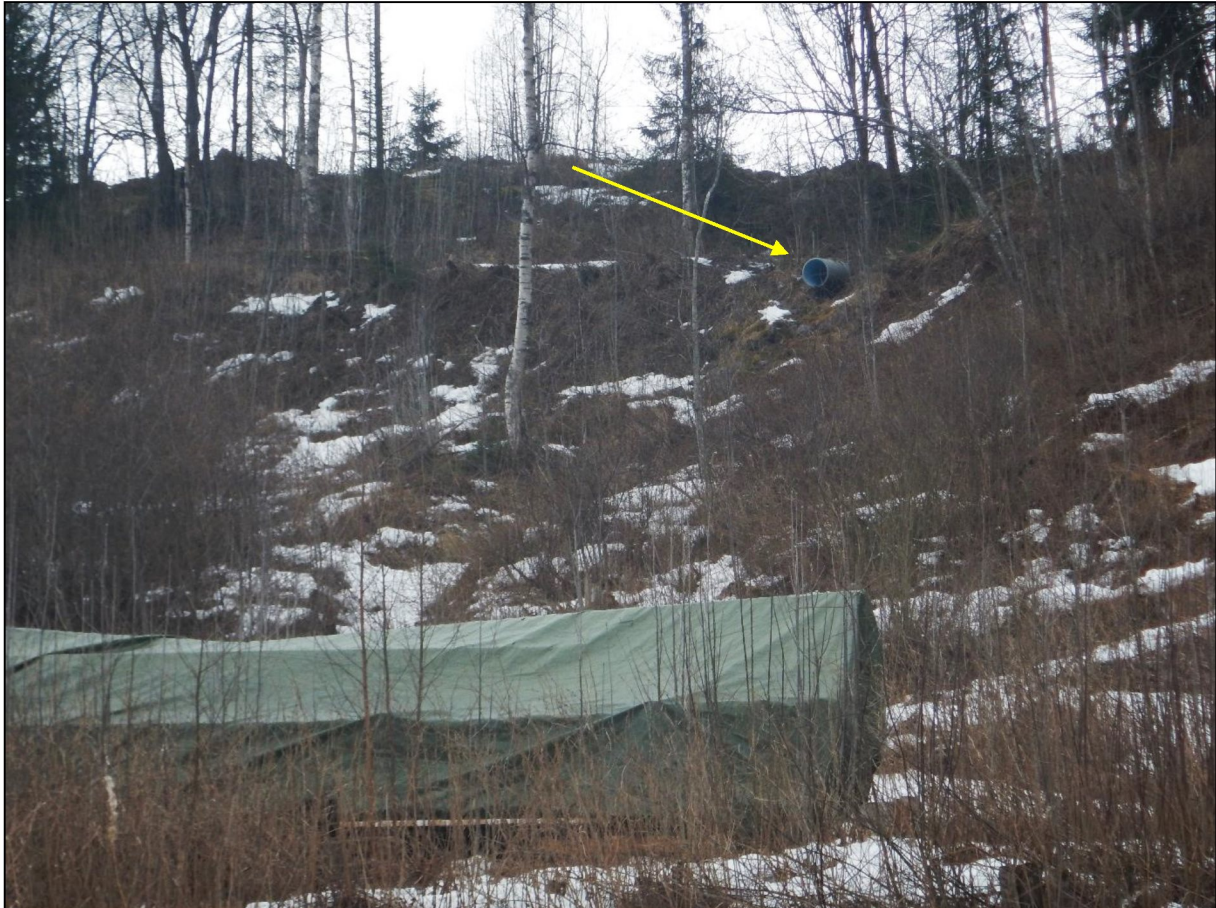
Figur 21: Kulvert som munner ut i bratt løsmasseskråning ovenfor Vollskogveien (gul pil).
