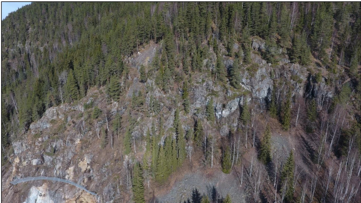
Figur 16: Dronebilde av fjellskrenten mellom den nye veitunellen og Spangrud. Nede til venstre ser man noen av sikringstiltakene iverksatt i forbindelse med veianlegget.
