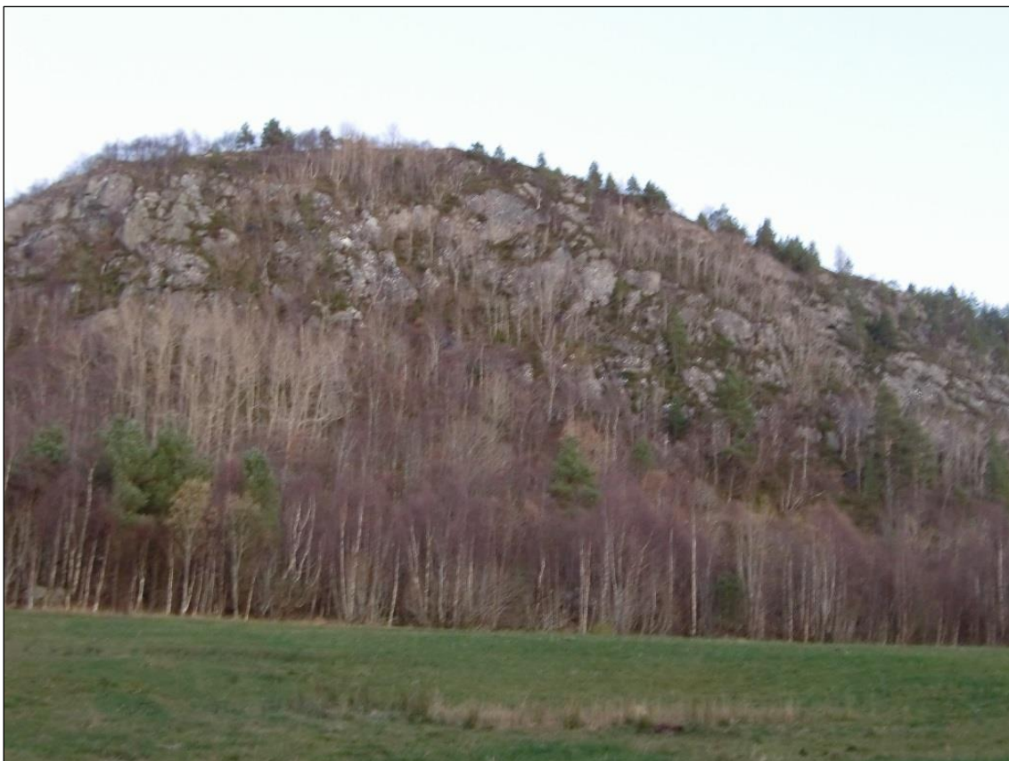
Figur 9-2: Bergskrent med sannsynlighet for steinsprang.
