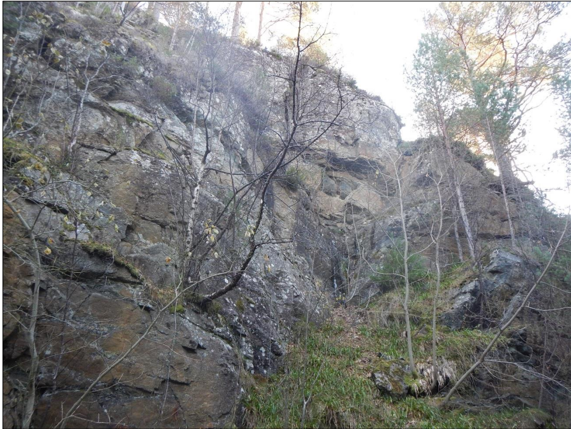
Figur 24-2: Skjæring ved vei
