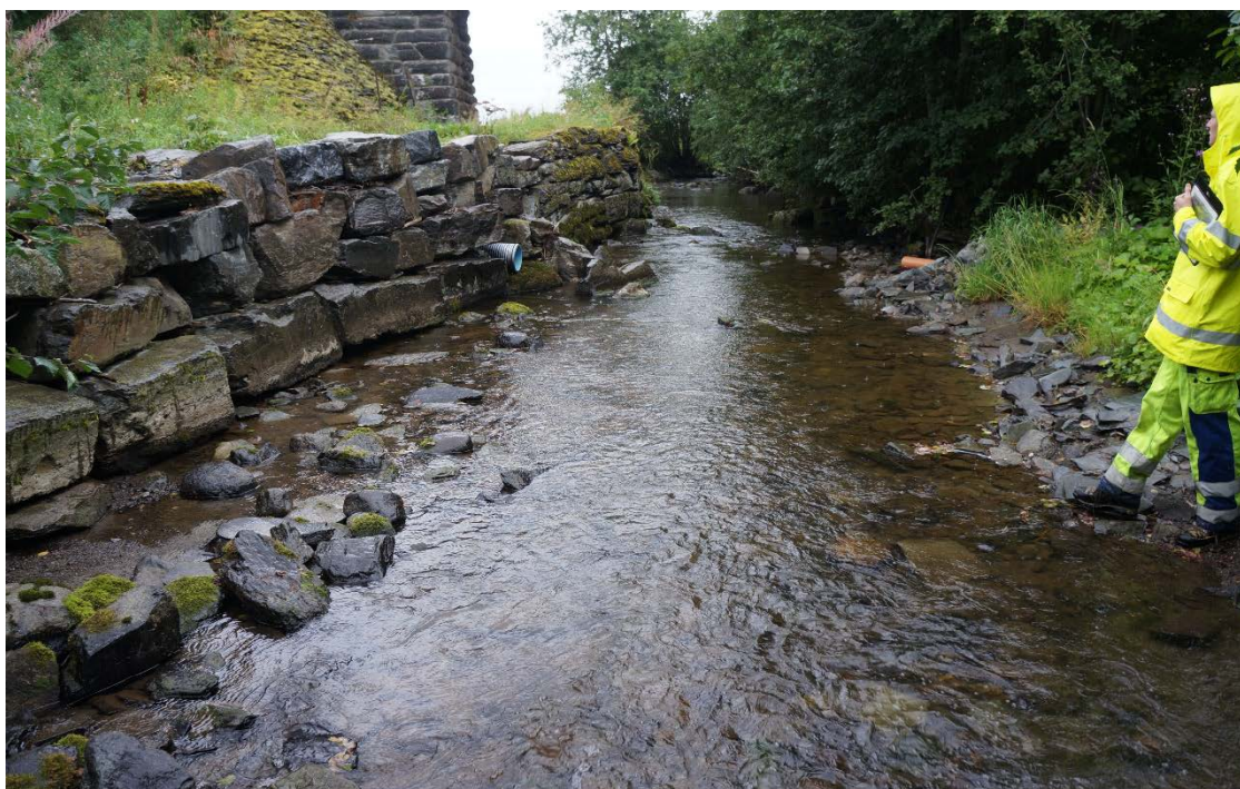
Figur 6 Muren for jernbanebrua ses i øvre venstre del av bildet. Venstre elvebredd, som avgrenser kvikkleiresonen Rinnan, er murt opp med stor stein, mens høyre elvebredd er slak.
