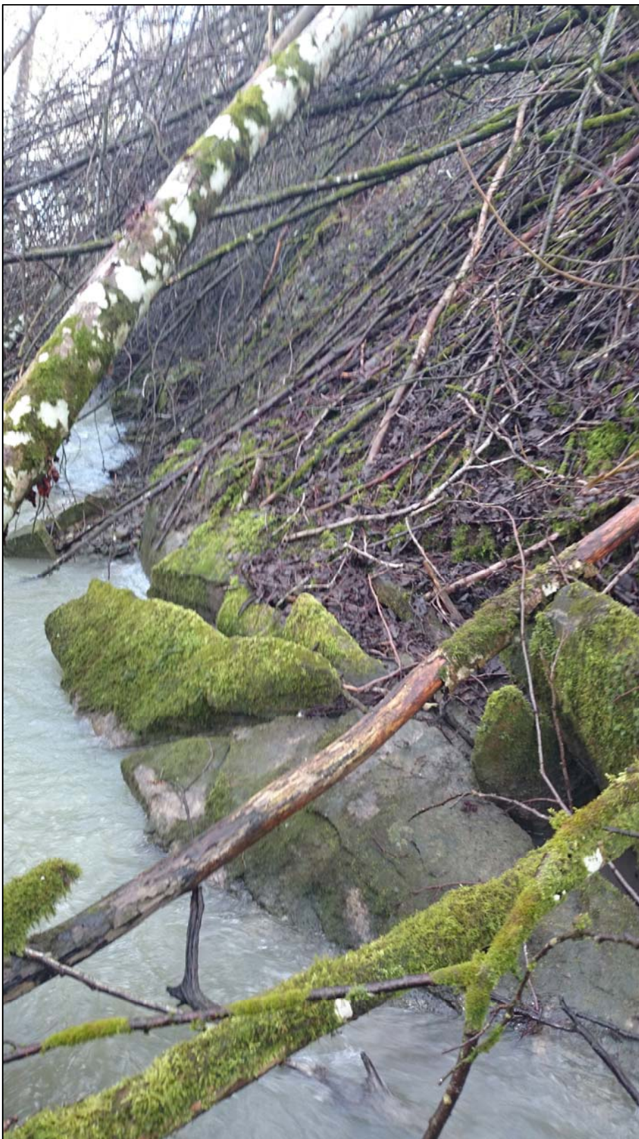
Bilde 11 – Gammel plastring? En del veltede trær, tyder på bevegelse i skrånningen.
