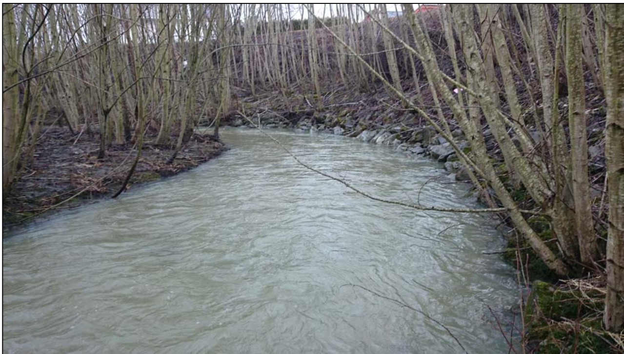
Bilde 4 – Plastring yttersving
