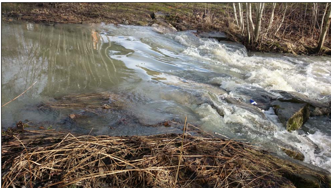
Bilde 9 – Liten oppdemming til masselagringsbasseng
