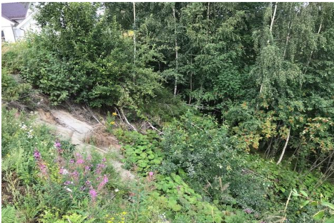
Bilde 9. Viser dagens situasjon i rasområdet (2019)
