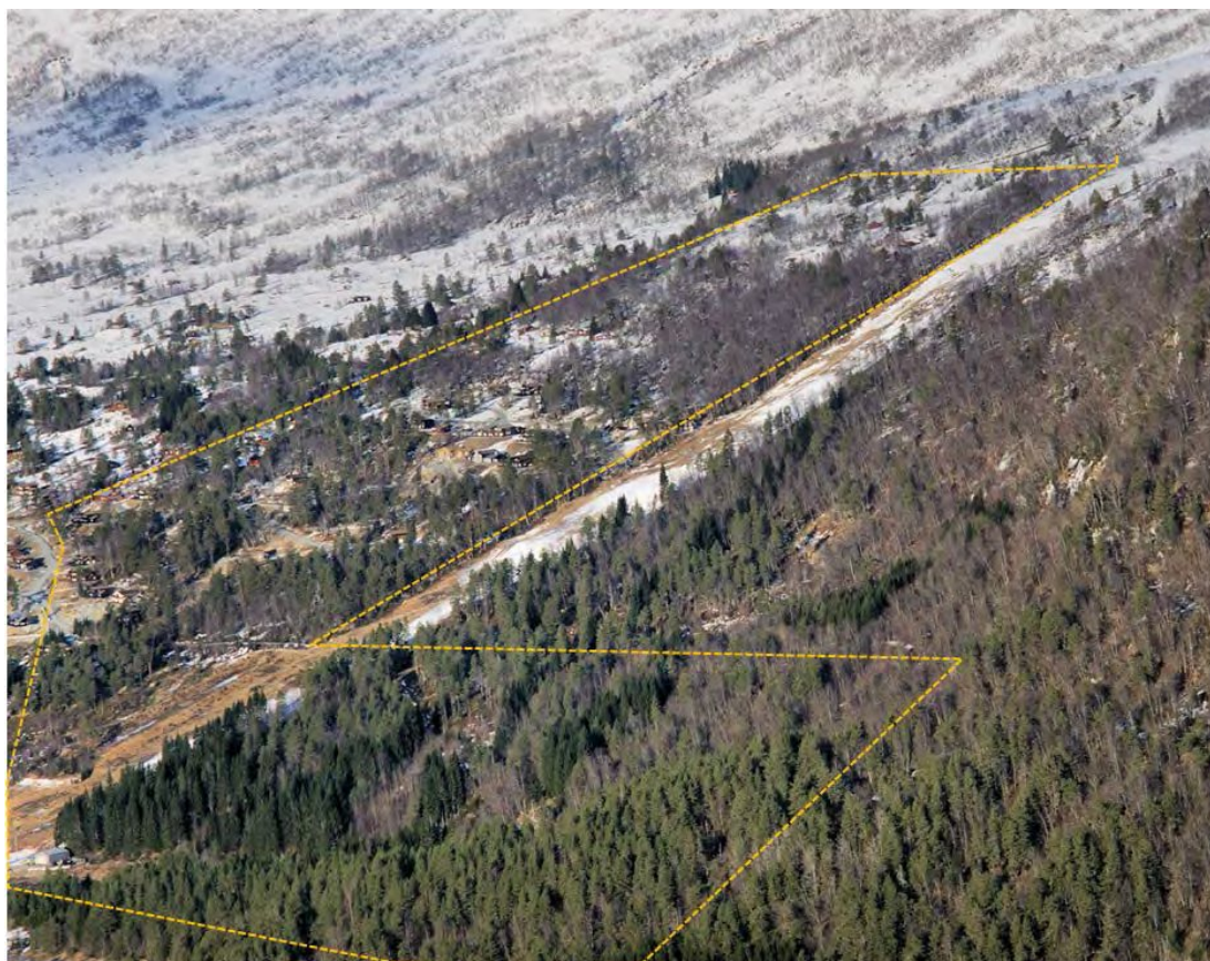
Figur 25. Oversiktsbilde over område 2 ved Stryn Skisenter som viser det ubebygde skogklede området nederst i bildet og området nord for hovedskiløypa som for en stor del er bebyggt. I overkant av det siste området går en det også en skiløype på skrå mot nordvest.
