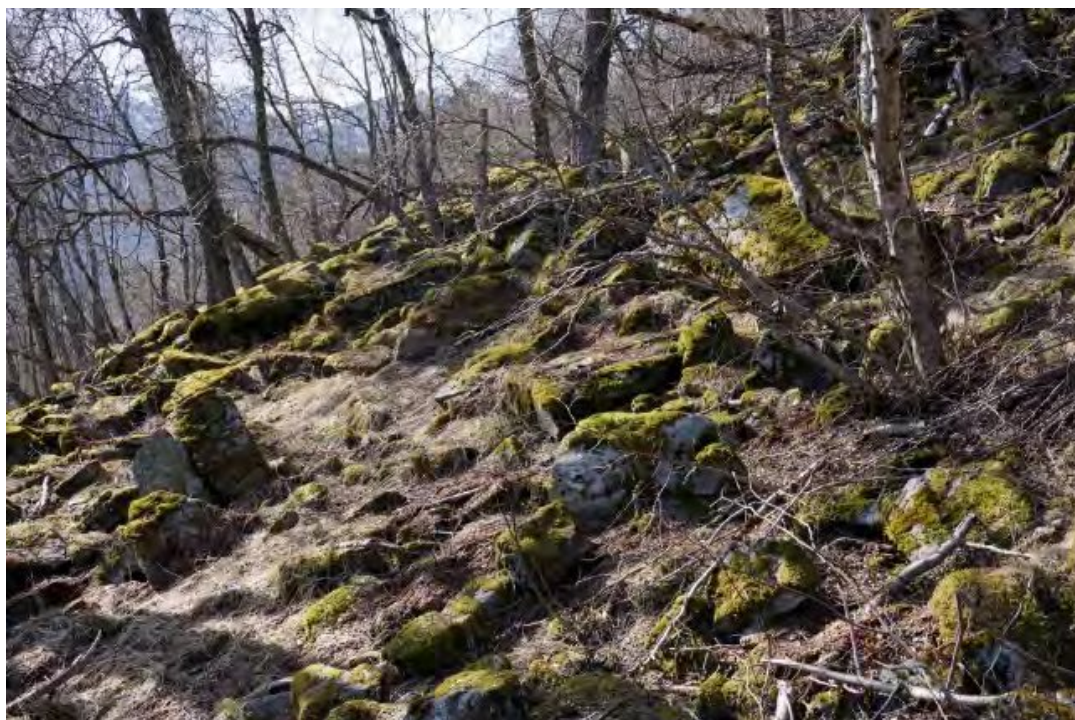
Figur 21. Ved fjellfoten til Gryta er det mange spor av eldre skredhendelser i form av jord- og flomskred. De ferske skredsporene stammer mest fra mindre stein- og snøskred (se befaringsprotokoll).
