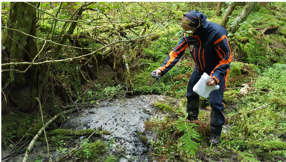
Figur H12 Bekken mellom sone 719 Gran og 732 Gran øst eroderer i leire. Foto: J. Wasrud, NVE
