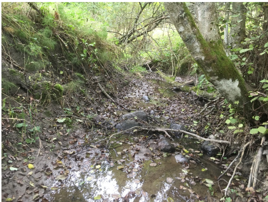
Figur H16 Lite erosjon i nedre del av bekken nær P6, kvikkleiresone 724 Årsrud
