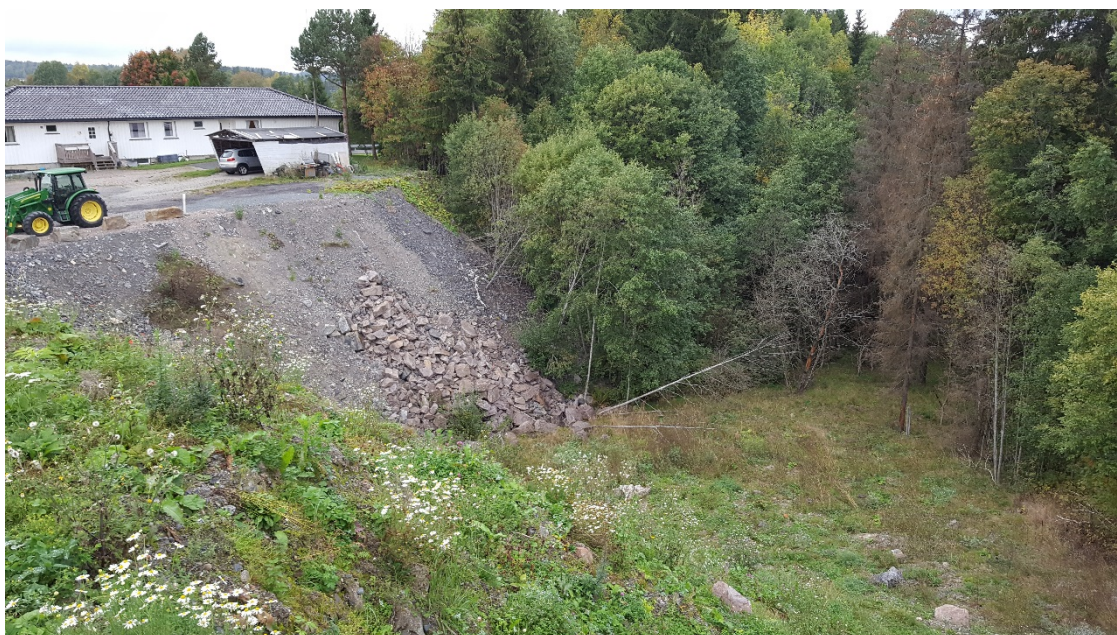
Figur H5 Oppfylling i øvre del av ravinen øst for sone 719 Gran. Øverst: Oversiktsbilde tatt fra toppen av oppfylt område. Nytt terreng ligger vesentlig høyere enn tidligere. Nederst: Utfylling øst for garasjen ned i ravinen. Foto: J. Wasrud, NVE
