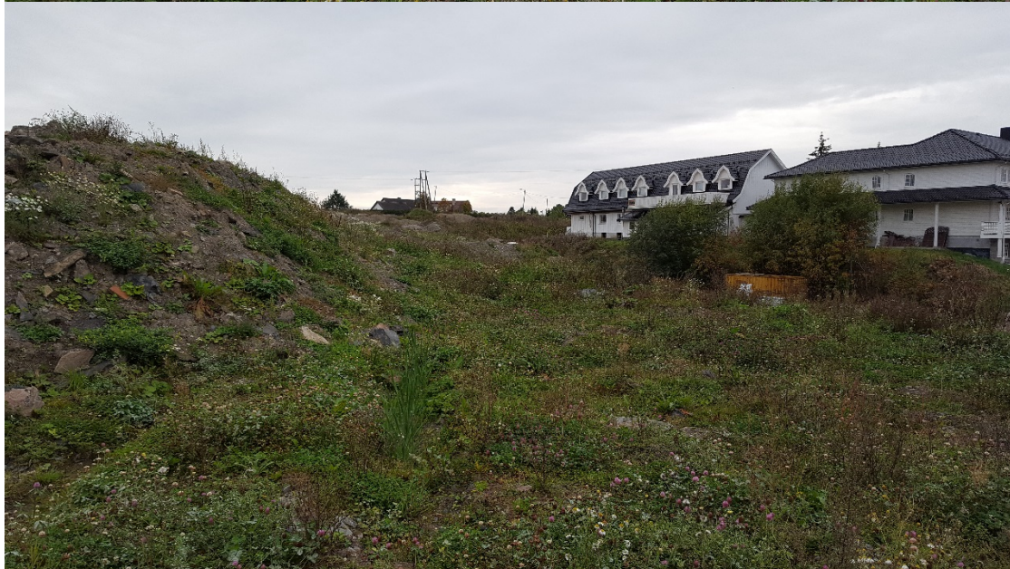
Figur H6 Oppfyllingen i kvikkleiresone 719 Gran har betydelig mektighet over tidligere terreng. Øverst: Sett mot sørøst. Nederst: Sett mot sør. Foto: J. Wasrud, NVE
