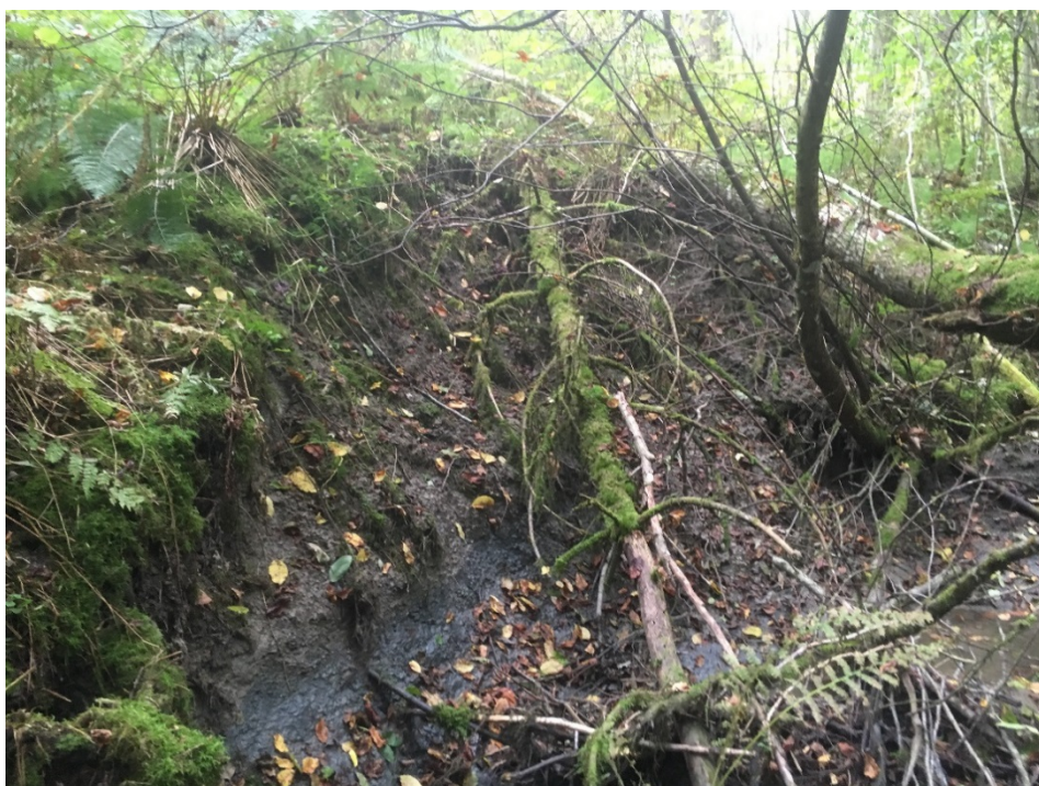
Figur H19 Lokal overflateutglidning opp til 2-3 m over bekken som følge av erosjon nær P8, kvikkleiresone 724 Årsrud. Fersk leire eksponert nederst i skråningen.
