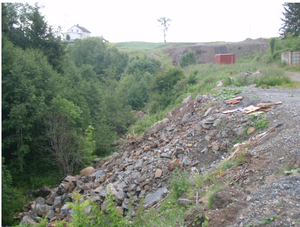
Figur H9 Fotografi fra befarings (ref. /H4/). Bildet er tatt omtrentlig ut fra den nye garasjen angitt i Figur H8. Merk utfylling lenger opp i ravinen. Fyllingskanten lå på dette tidspunkt mye lenger sør enn i 2016.
