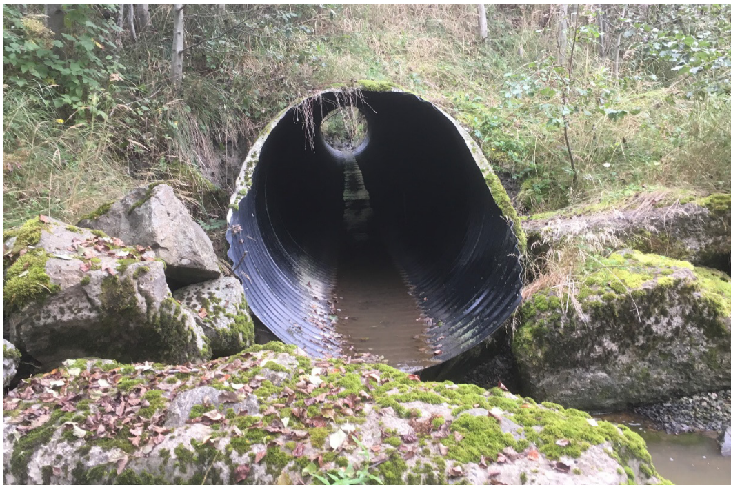
Figur H24 Bekk i kulvert under Gjevikvegen nord i sone 723 Nordli
