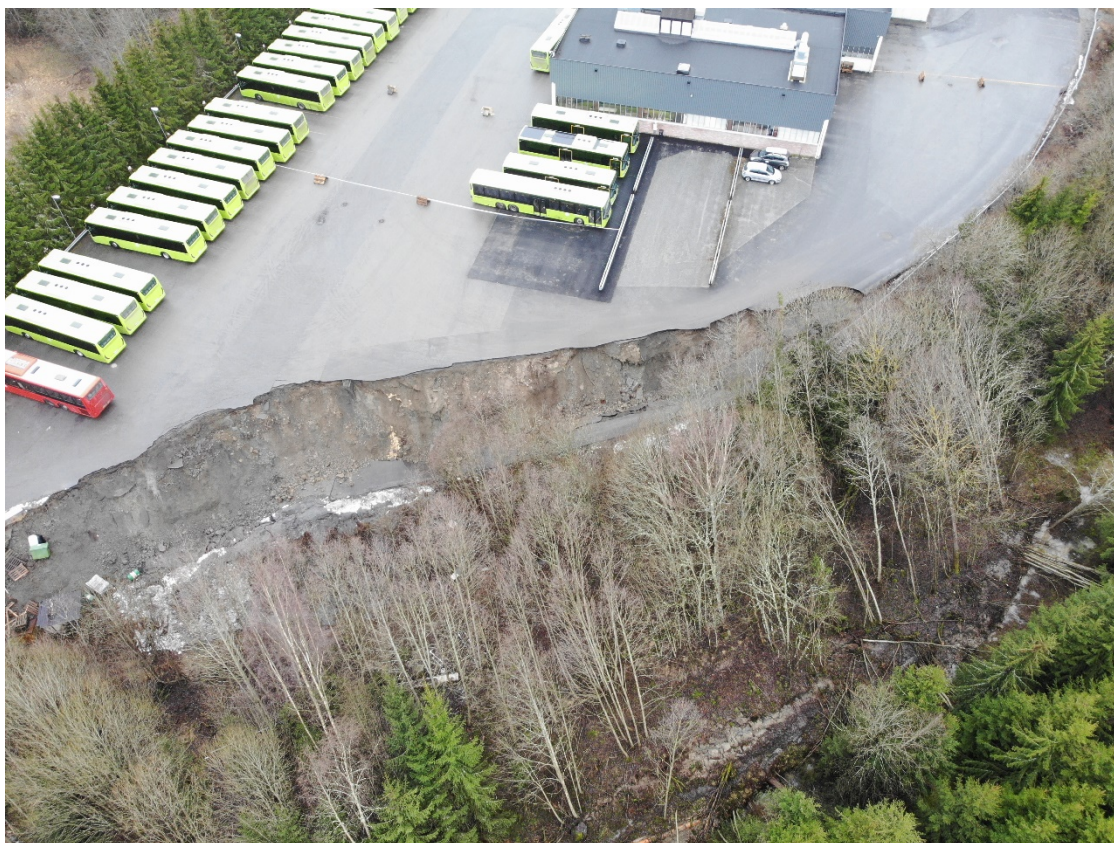
Figur 2. Bilde av skredet tatt med drone (kilde: Follo brannvesen).
