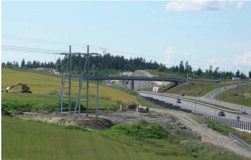
Bilde 3-2 Kabelendemast, fra 132kV Rød - Jåberg i Vestfold.
