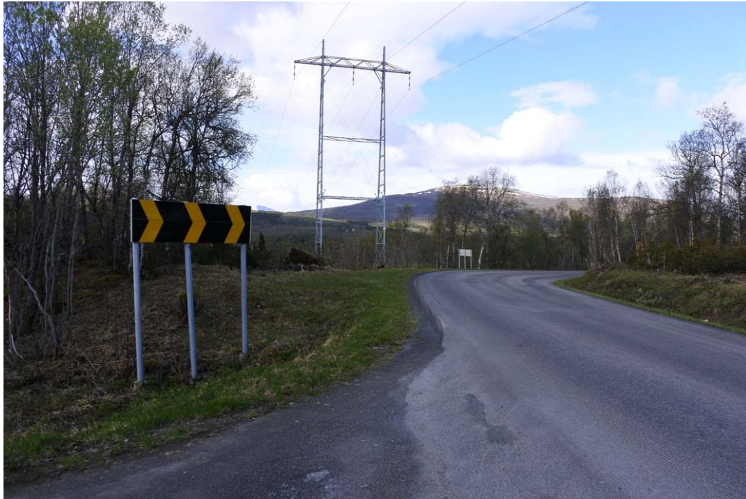
Bilde 3-1 Dagens mastetype, tilsvarende mast, men som vinkelmast, vil bli satt opp.
