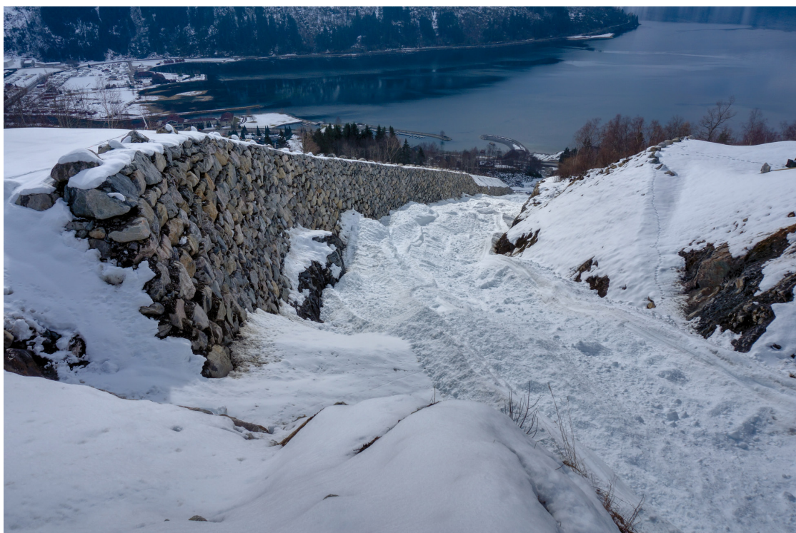
Figur 9. Snøskredet fra begynnelsen av mars 2016 viser ikke tendens til oppstuvning av skredmasser eller vesentlig grad av klatring langs vallsiden. Der det er noe tendens til klatring er i området hvor vollen har bort imot den største effektive høyden.
