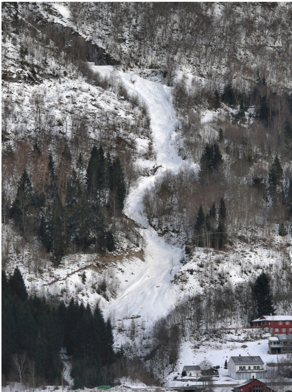
Figur 6. Bildet viser elvefaret fra Gjølmunna med et snøskred fra desember 2011. I overkant av løpet er den da eksisterende elveforbygningen godt synlig.
