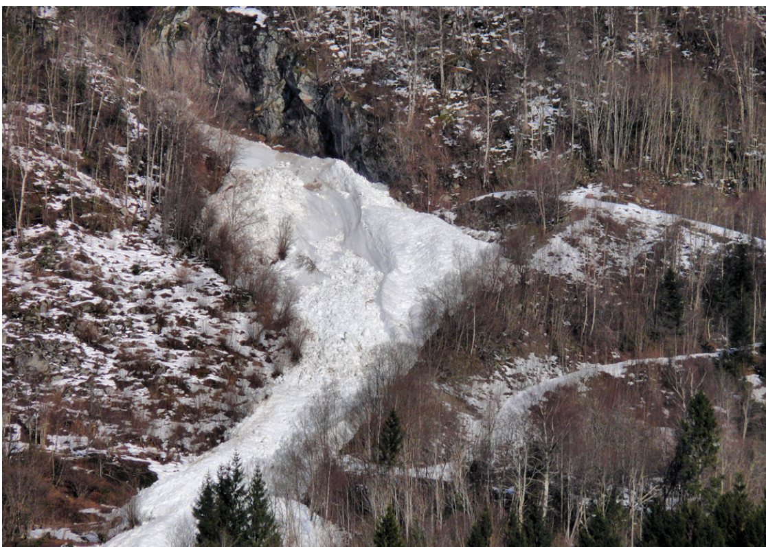
Figur 7. Snøskred i desember 2011. En del av skredmassene har stuvet seg opp i utløpet mot forbygningen, noe som reduserer effekten av denne i forhold til etterfølgende skred.
