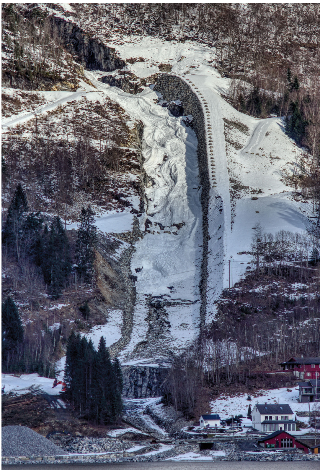
Figur 8. Snøskred fra begynnelsen av mars 2016. Skredet har gått ned 3/4 av vollengden og har fordelt seg nokså jevnt i kanalen.
