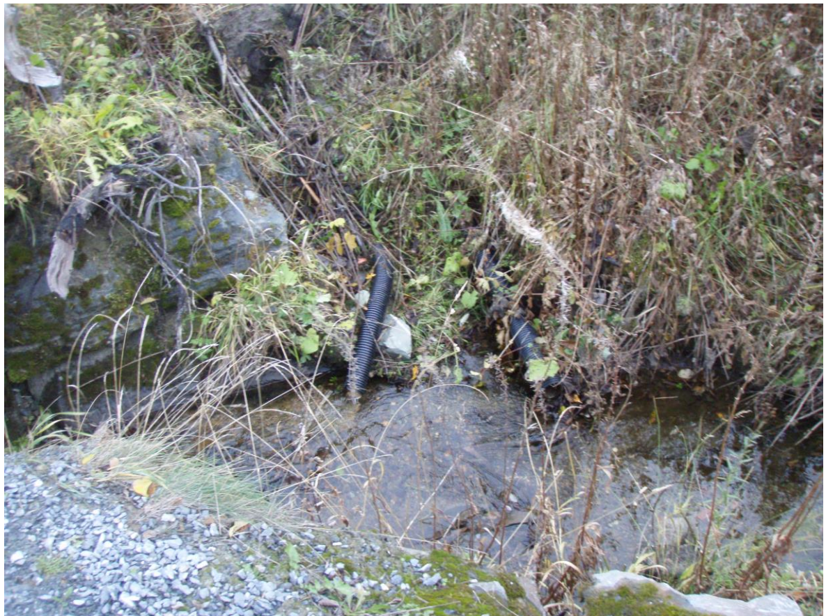
Profil B. Borpunkt 2. Drenering i foten av skråningen.
