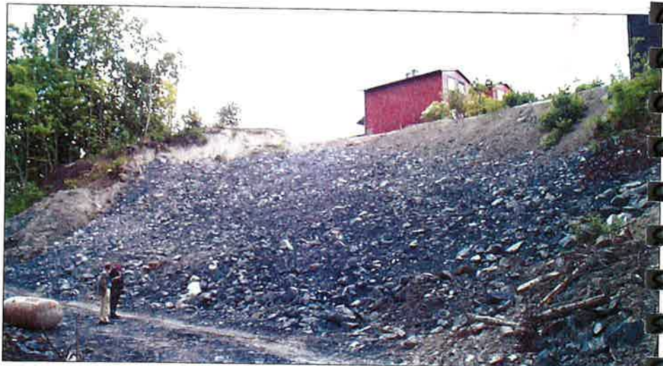
Boligfelt i Lahelle, Lier kommune. Det er kommunens ansvar å forebygge sårbarhet og risiko. Utarbeidelse av arealplaner og avgrensning av fareområder er en svært viktig del av kommunens sikringsarbeid. Plan- og bygningsloven stiller krav om tilstrekkelig sikkerhet mot farer eller vesentlig ulempe som følge av natur eller miljøforhold. Her ble et hus revet etter skred.
