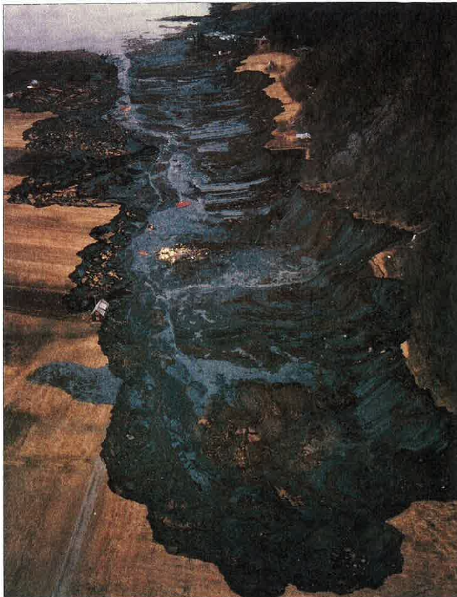
Rissaraslet ga oppstarten til kartleggingen av kvikkleireområder med potensiell skredfare. Skredgropen er 1,5 km lang. Skredet ble utløst etter omlagring av masser fra en byggegrop nederst ved vannet. Foto: Aftenposten
