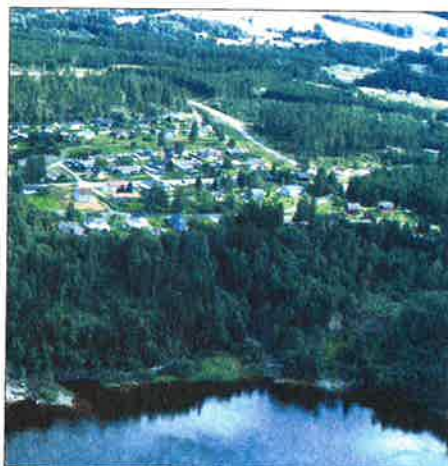
Boligfelt i Hvittingfoss, Kongsberg kommune. Boligfeltet ligger på en kvikkleiresone. Etter flere ras på skrenten mot Numedalslågen og evakuering av husstander, ble skrenten sikret høsten 2001. Foto: S. Dahlgren
