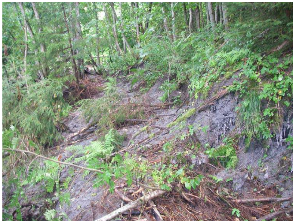
Figur 2 Erosjon i foten av skråningen (foto 8. august 2007).
