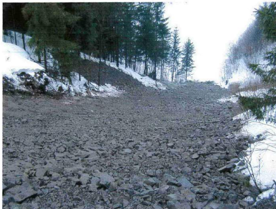
Fylling sett ned mot elva i nord
