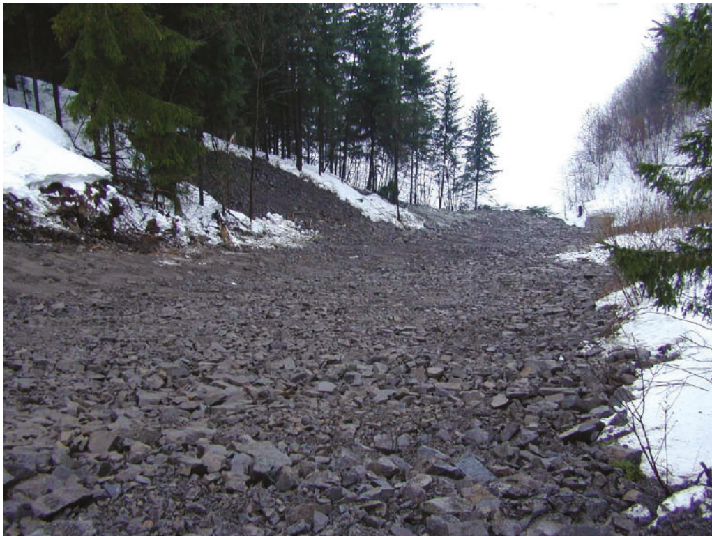
Fylling sett ned mot elva i nord
