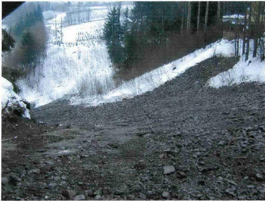
Fylling sett mot dalside nord for Fossveien 80
