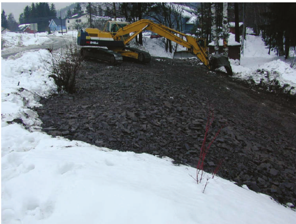
Topp av fylling sett mot sørvest
