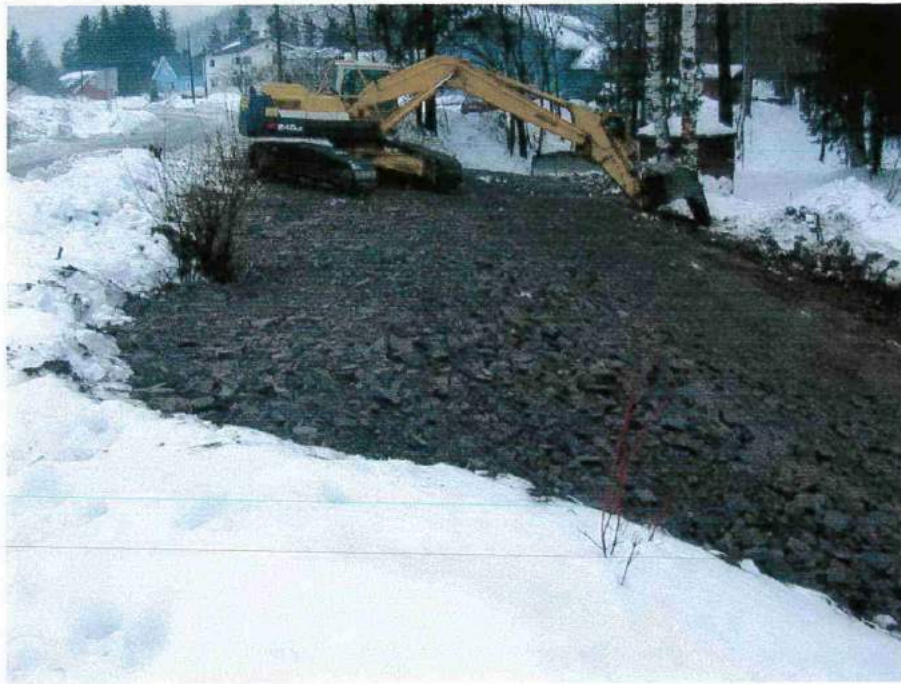
Topp av fylling sett mot sørvest
