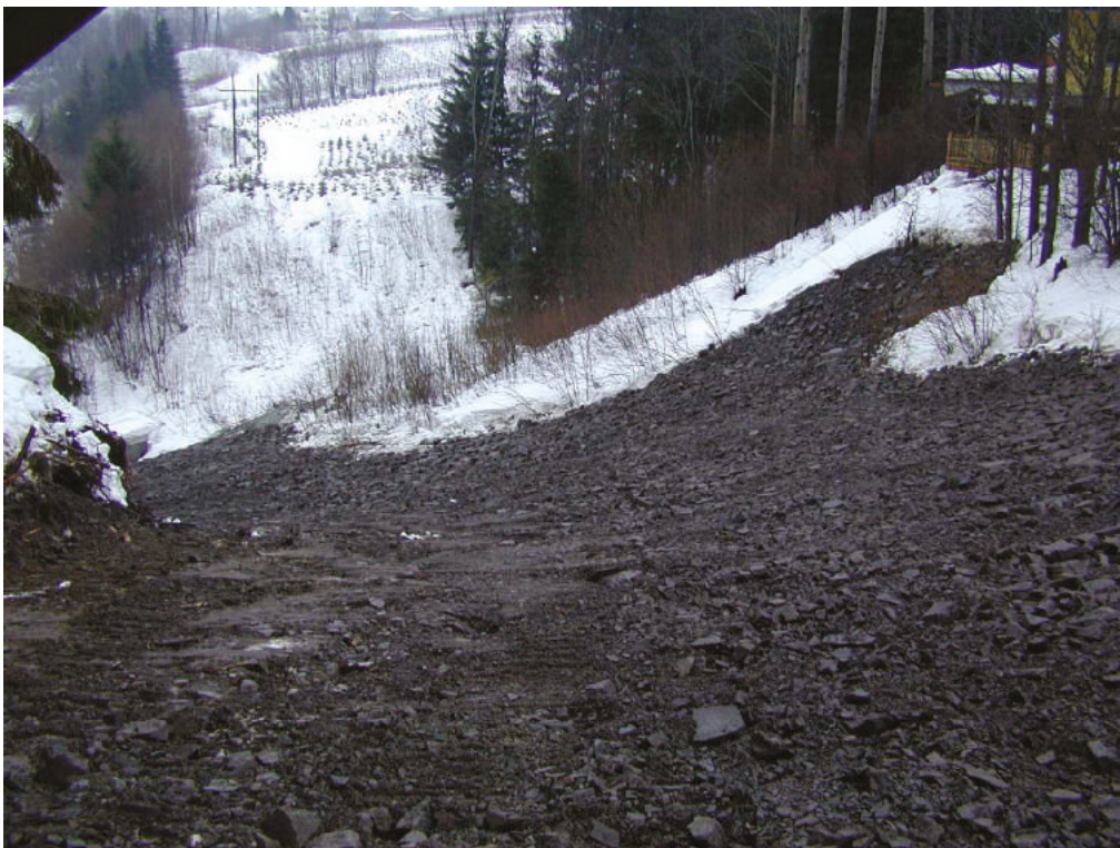
Fylling sett mot dalside nord for Fossveien 80
