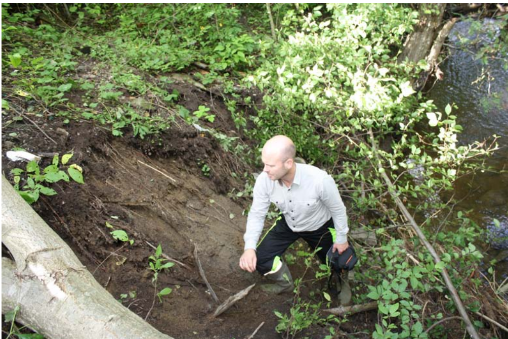
Figur 3 Utrasningen i overflatemassene medfører økt erosjon i skråningen
