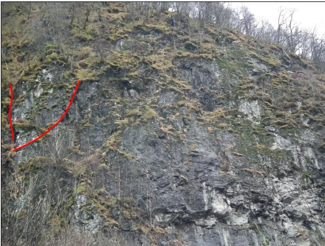
Figur 13: Fjellskrenten "Teigane" ved lokalitet D. Vest i figuren sees et bergparti som har antydninger til sprekker som avgrenser det (rødt markering).
