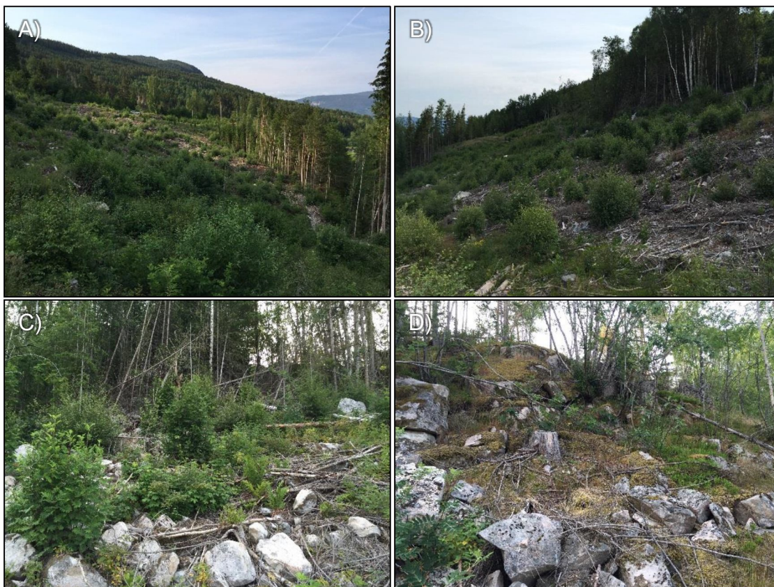
Figur 3: Bilder fra reguleringsområdet. A) Den øvre (østlige) delen av området, sett mot nord. B) Den øvre (østlige) delen av reguleringsområdet sett mot sør. C) Et brattere parti i den øvre delen av området. Her kan enkelte av løsmassene komme i bevegelse. D) En skrent hvor det finnes enkelte avgrensede blokker som bør sikres.
