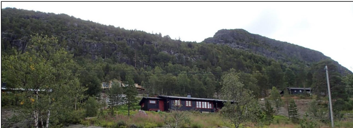
Figur 4: Bilde av Hartevasnibba til høyre, og hyttefelt mot rv. 9. Oppsprukket granitt er synlig i høydedraget bak hyttene, under de vertikale skrentene ligger det ur i skogen.
