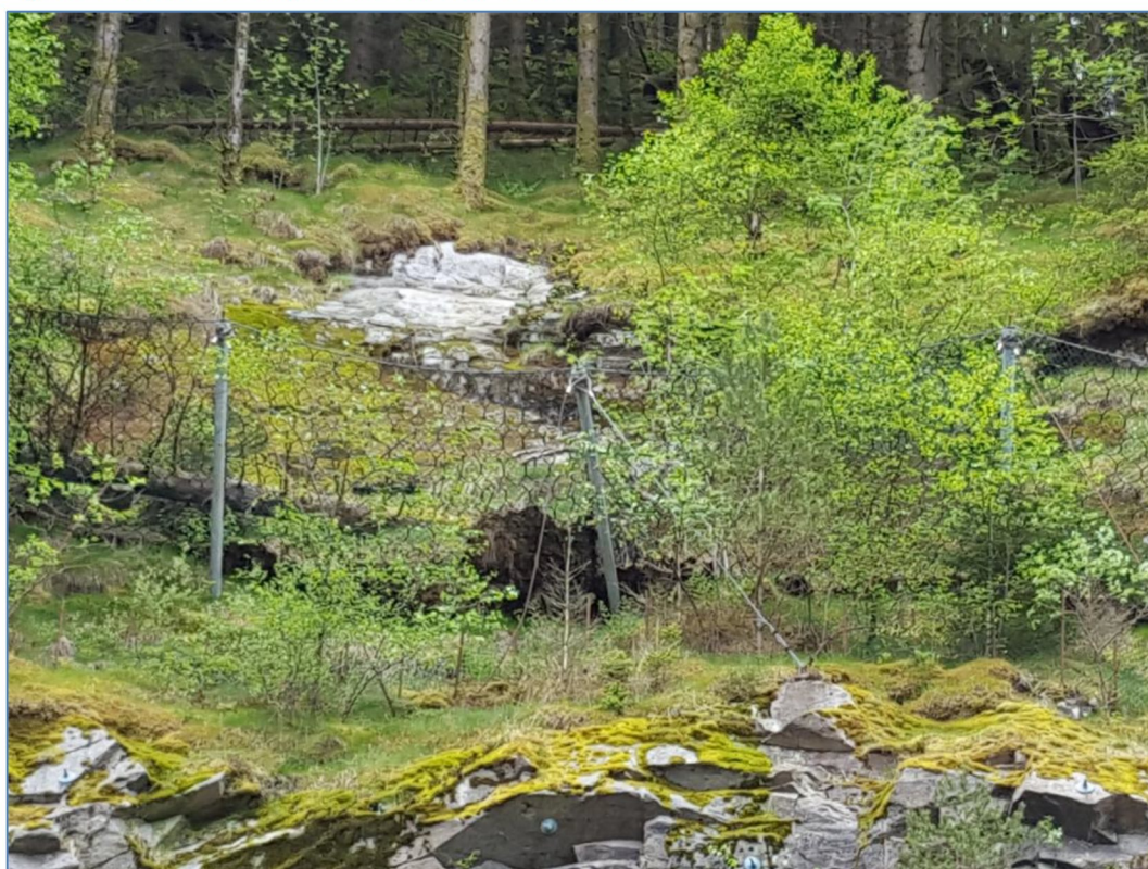
Figur 4. Bilde av skrâning over tunnelåpning ved industriområdet i sørvest av utredningsområdet. En rotvelt har eksponert berg under et tynt vegetasjonsdekke.
