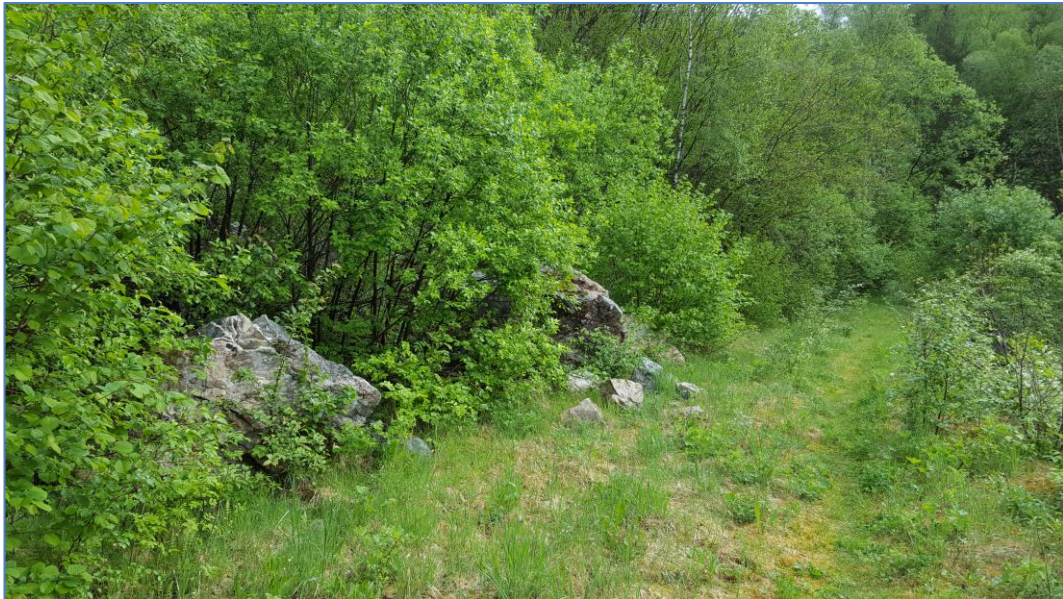
Figur 9. Forholdsvis nylig utraste blokker ned på "skogsvei" opp til vannet.
