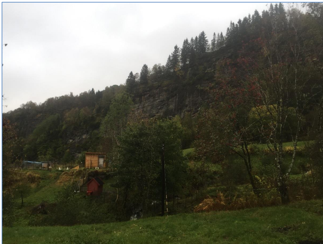
Figur 5: I området ved Yksnebjør er det i felt observert betydelige løsmasser, og bekkeleiet er skåret flere meter ned i dette.
