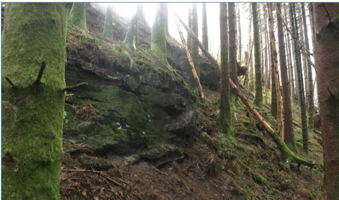
Figur 5: Et tynt løsmassedekke preger den øvre, nordlige delen av området. Her vises en liten bergskrent hvor det har løsnet mindre blokker. Blokkene har stoppet kun noen få meter i underkant.
