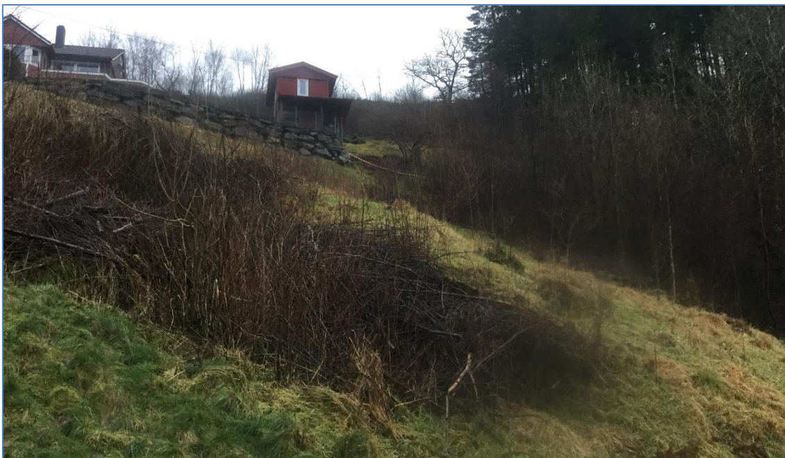
Figur 4: Et eksempel på det bratte, løsmassedekkede terrenget som preger den sentrale delen av området. Bildet er tatt mot nordvest fra et punkt rett i overkant av skredgropen fra skredet som gikk den 7. desember 2012.
