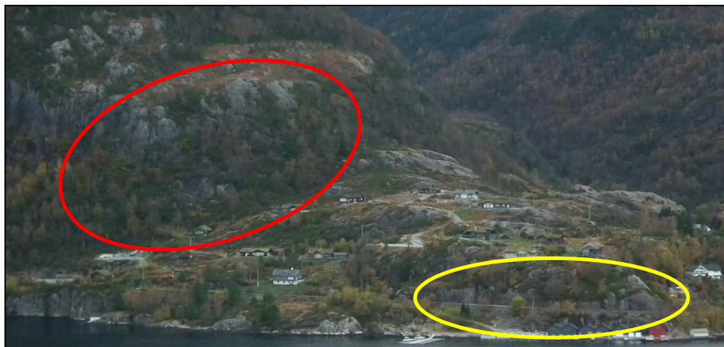
Figur 37: Oversikt over område 9 og 10. En bratt skråning i nord er markert i rødt, mens en liten skrent langs veien er markert i gult.
