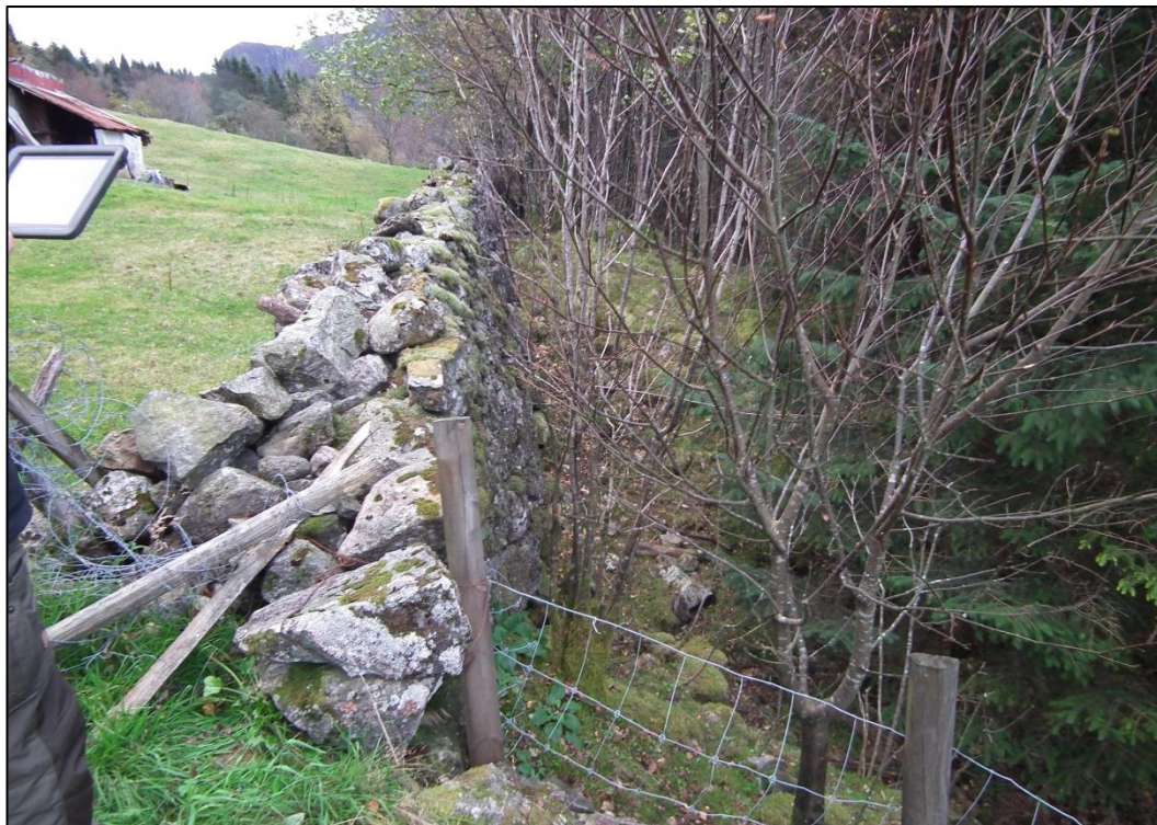
Figur 15: Ravine sentralt i område 3. Ravinen har opprinnelig gått fra venstre i bildet mot høyre, men er blitt fylt igjen i den øvre delen. Låven i figur 14 kan skimtes øverst til venstre i bildet.
