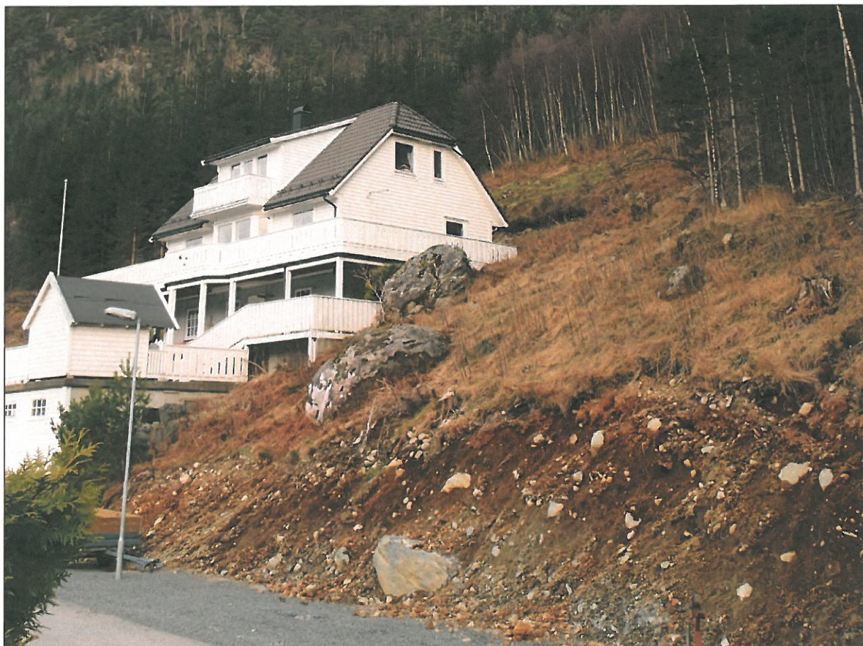
Figur 4: Foto av løsmassene øverst i boligfeltet. Løsmassene består av tykke lag morene med blokker på overflaten.
