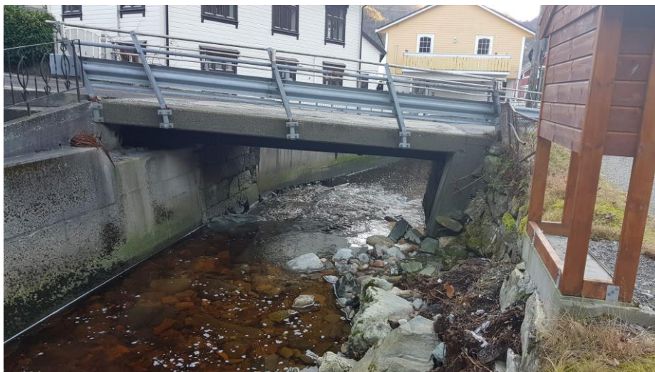
Figur 2-8 Vegbro over Haugelva
