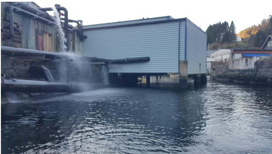
Figur 2-4 Overbygg over Sævareidvassdraget, sett medstrøms. På det meste er det en dybde på 5,5 m i nærheten av overbygget.
