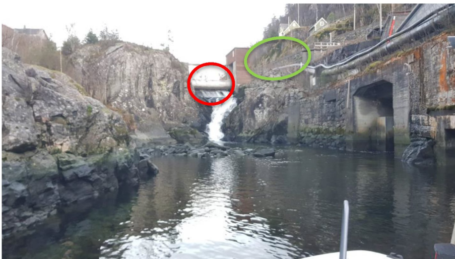
Figur 2-2 Sævareidvassdraget sett motstrøms. Lukedam sees bakerst i bildet, vist med rød sirkel. Inntakskanal er på høyre side av dammen vist med grønn sirkel
