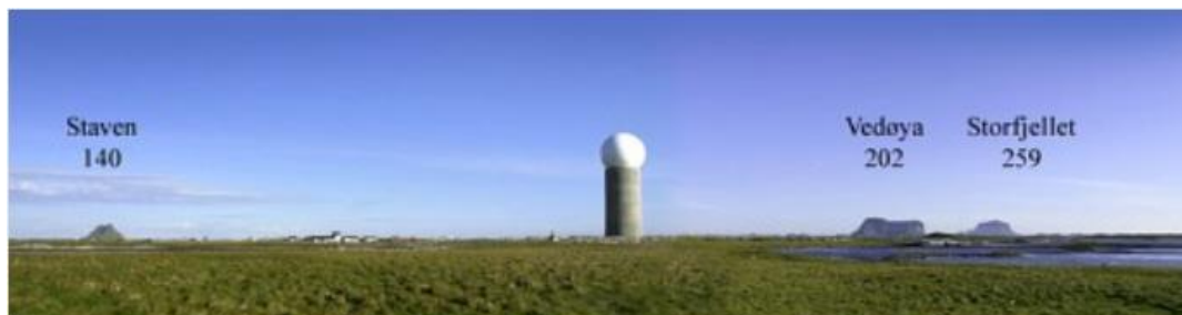
Figur 5 Bilde av værradaren på Røst som delvis blir skygget av små øyer med høye fjell i nærheten. Foto: meteorologisk institutt.
