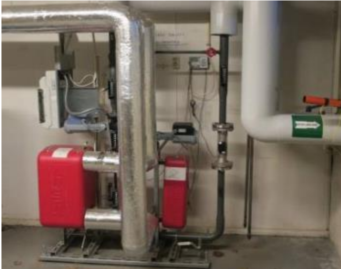
Figur 2, Eksempel på kundesentral med vekslere for varmt tappevann og oppvarming.
