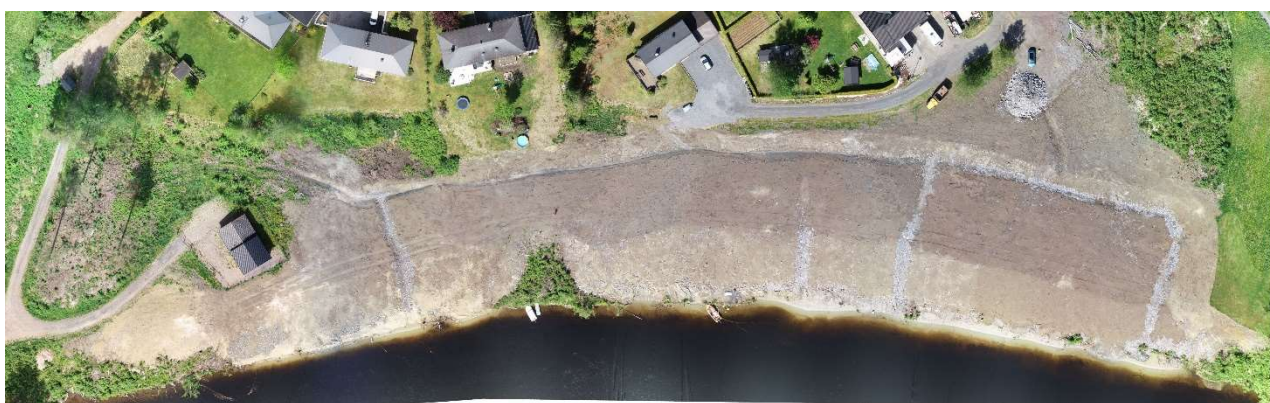
Figur 7 Evju etter utførte sikringstiltak
