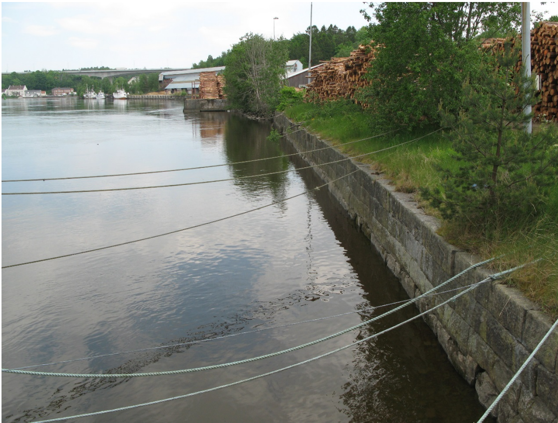
Bilde 13 Støttemur, øst for kai mot Glomma
