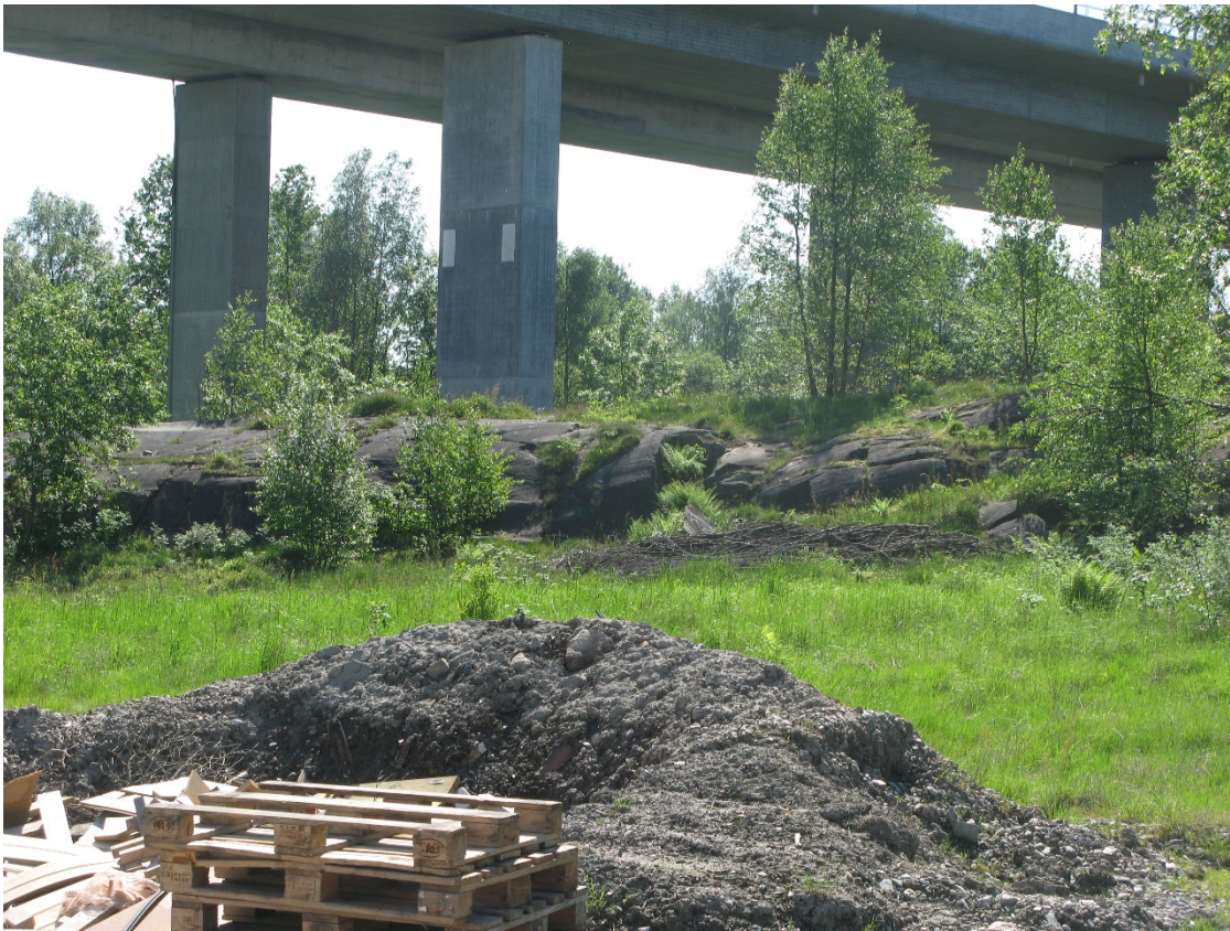
Bilde 5 Mellom E6 og Sundløkkaveien, sør for E6 landkar
