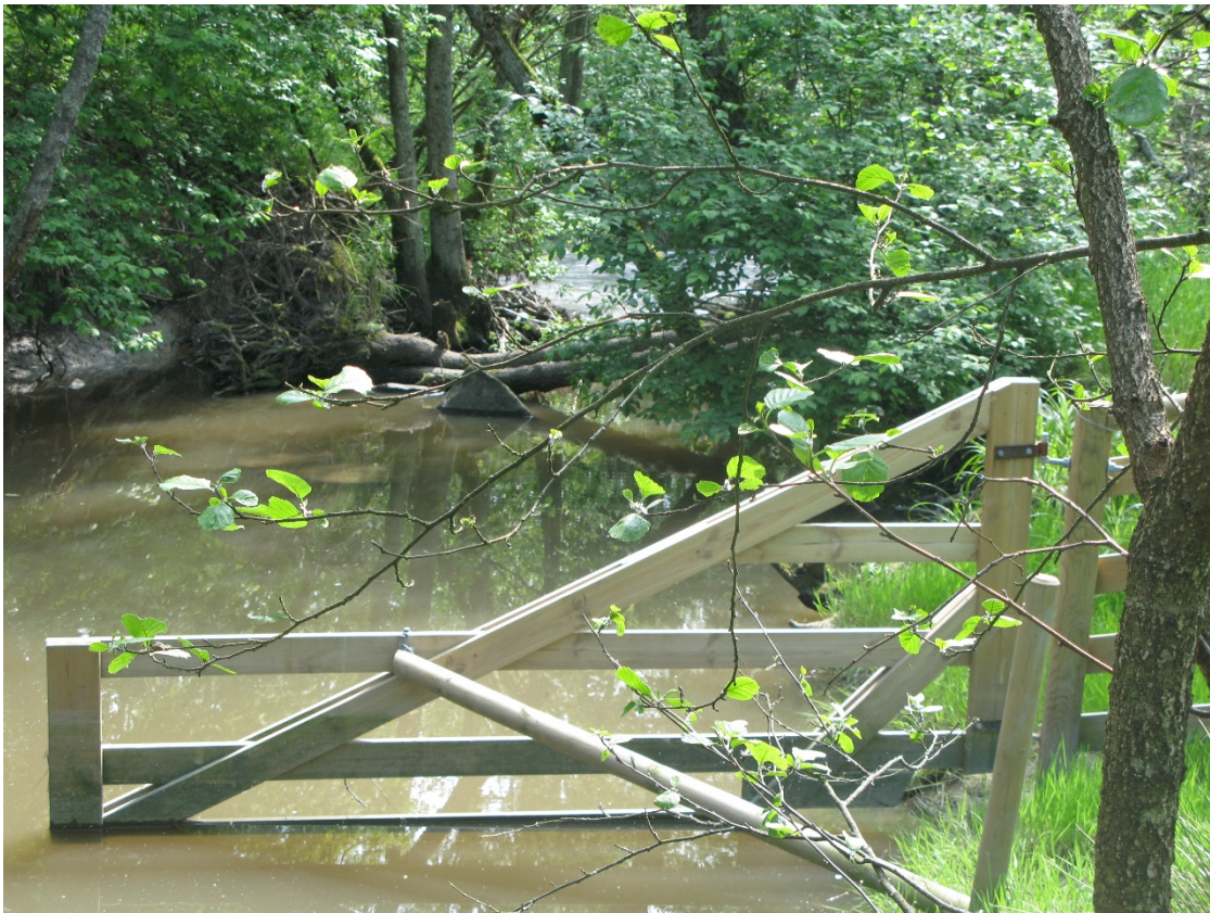
Bilde 20 Blokkering av Gretnesbekken nord for Sarpsborgveien
