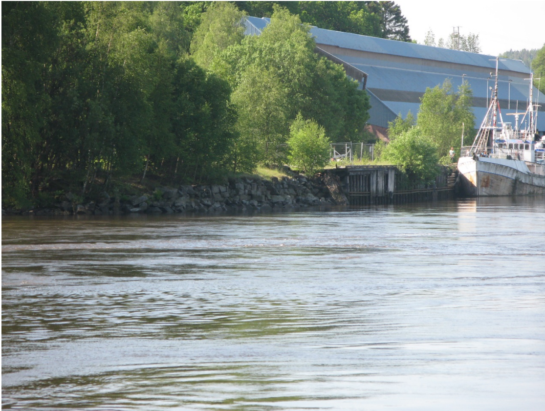
Bilde 9 Støttemur mot Glomma, øst for kai
