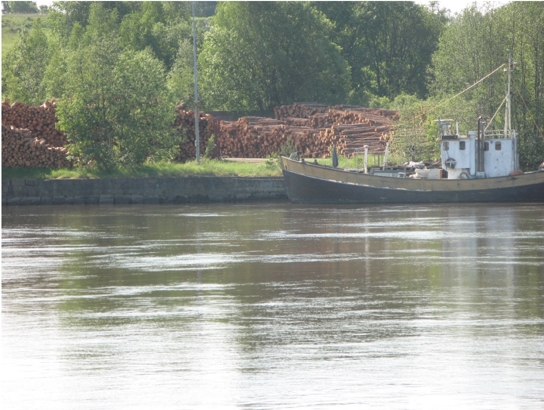
Bilde 12 Støttemur, øst for kai mot Glomma
