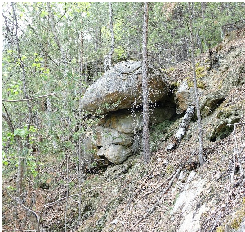
Figur 32: Fast fjell delvis forvitra som kan, med tida, bli utløyst som ei blokk med retning mot planområdet. Observert ved GPS punkt 1167.
