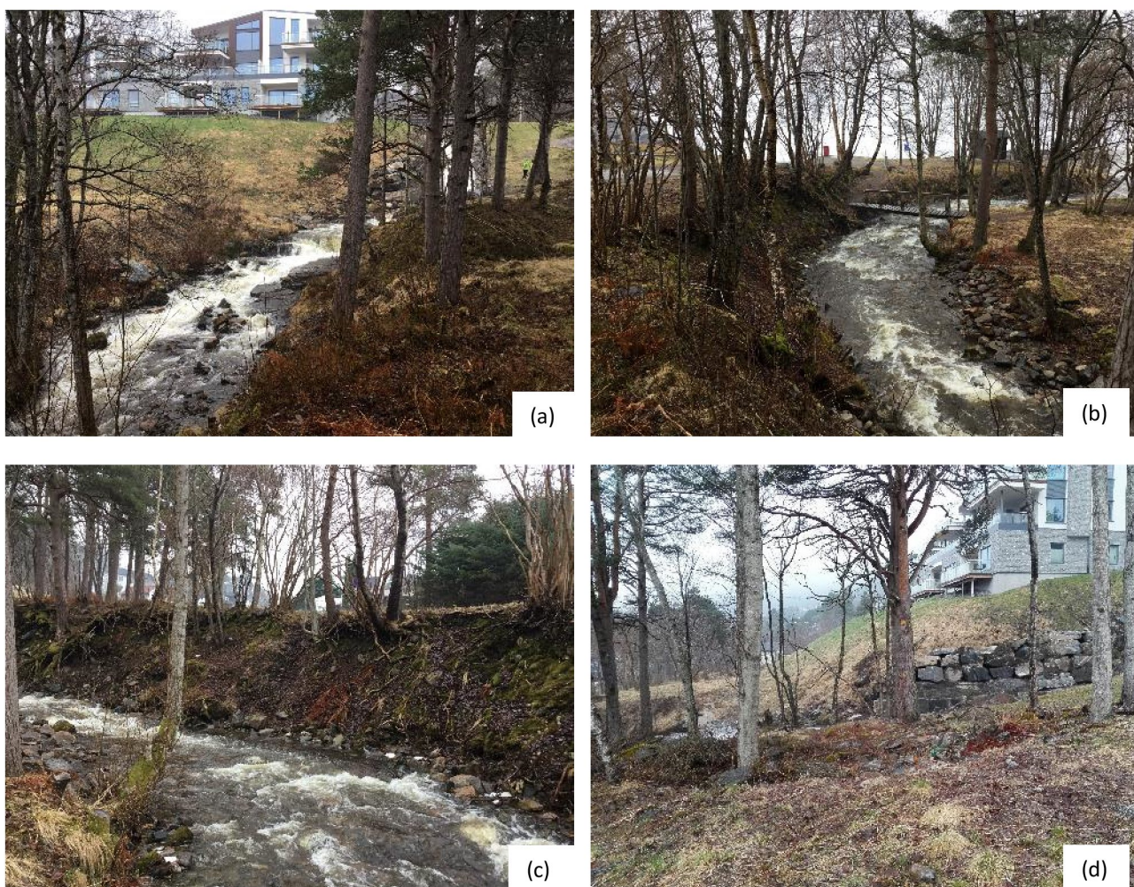
Figur 24(a) viser Mekelva fra bildepunkt 3984 oppstrøms og (b) nedstrøms. Bilde (c), punkt 3988, viser erosjon i elva, mens bilde (d), punkt 4022, viser terrenginngrep med utfylling foran boligblokk
