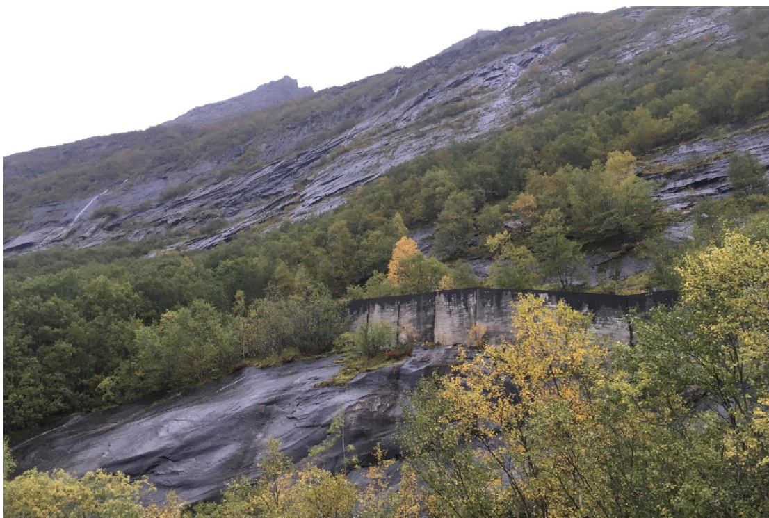
Figur 20 Mur før tunnelportal
