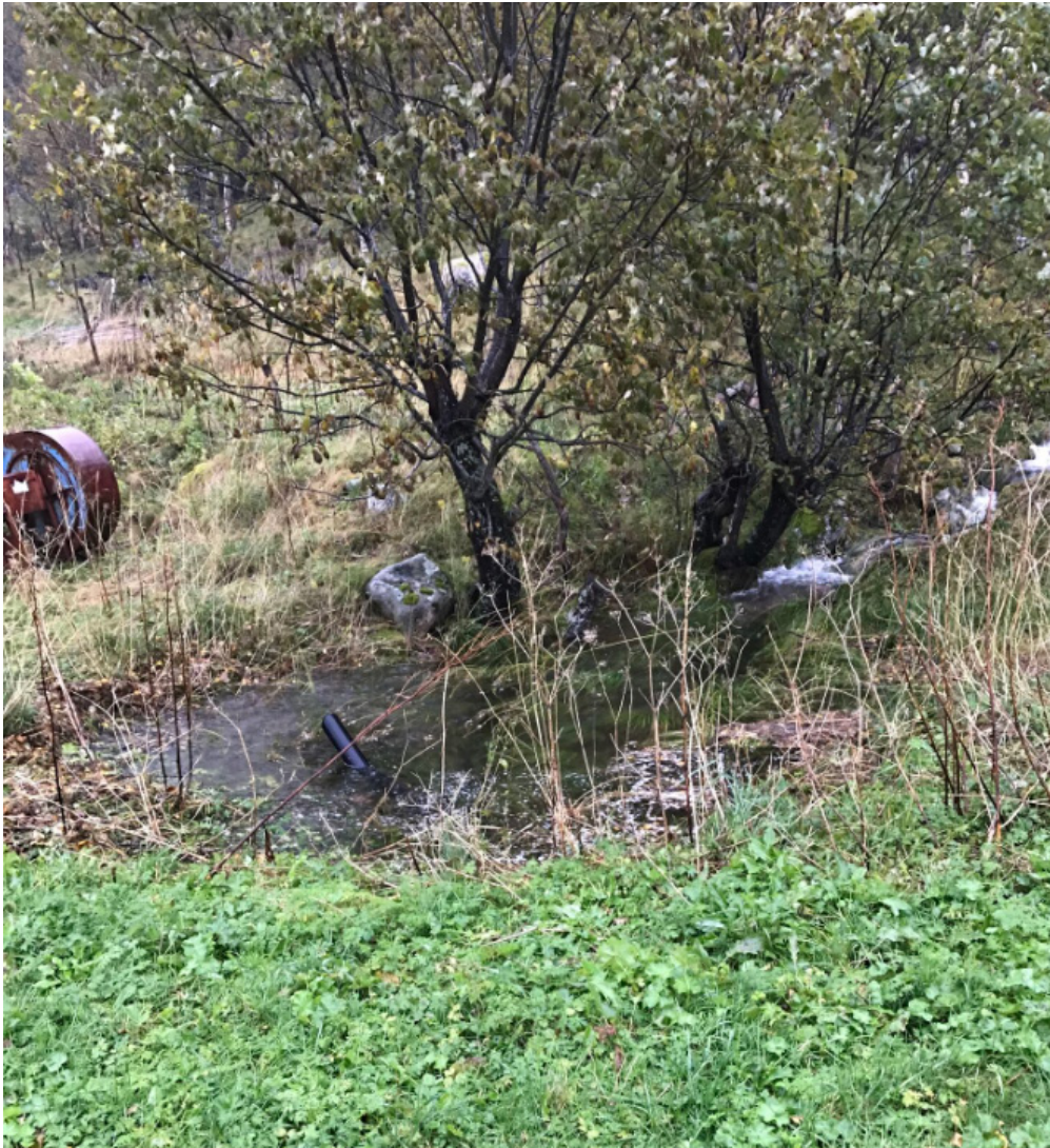
Figur 32. Inngang til rør der vann drenerer under dyrka mark. Under befaringen var det tydelig at noe vann hadde rent over og fortsatt på overflaten av jorden. Åsvik.
