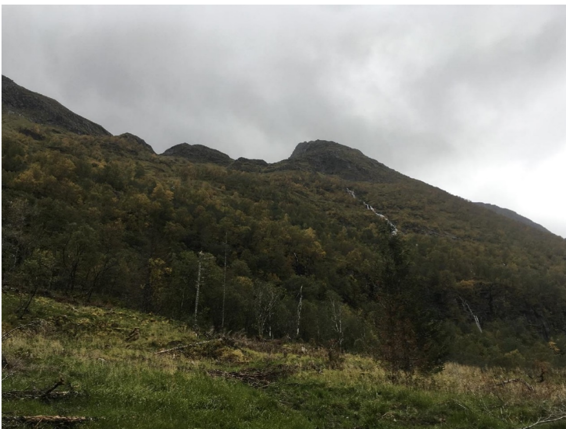
Figur 26 Stor bekk som kommer stor ut av fjellsida. Litt til venstre inn på fjellet er det et lavpunktssområde der det ikke står vann.
