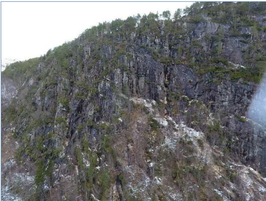
Figur 3: Bergskrent ved skråningen øst for Matre ved Littlefjellet hvor et sprekkesett som faller mot øst skimtes i berget. Bildet er tatt mot nordøst fra drone.
